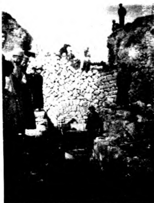
一拆卸城垣建築新洞嶺
