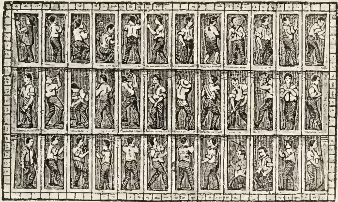
( Operaj lavoranti nella macchina, o scudo. )
