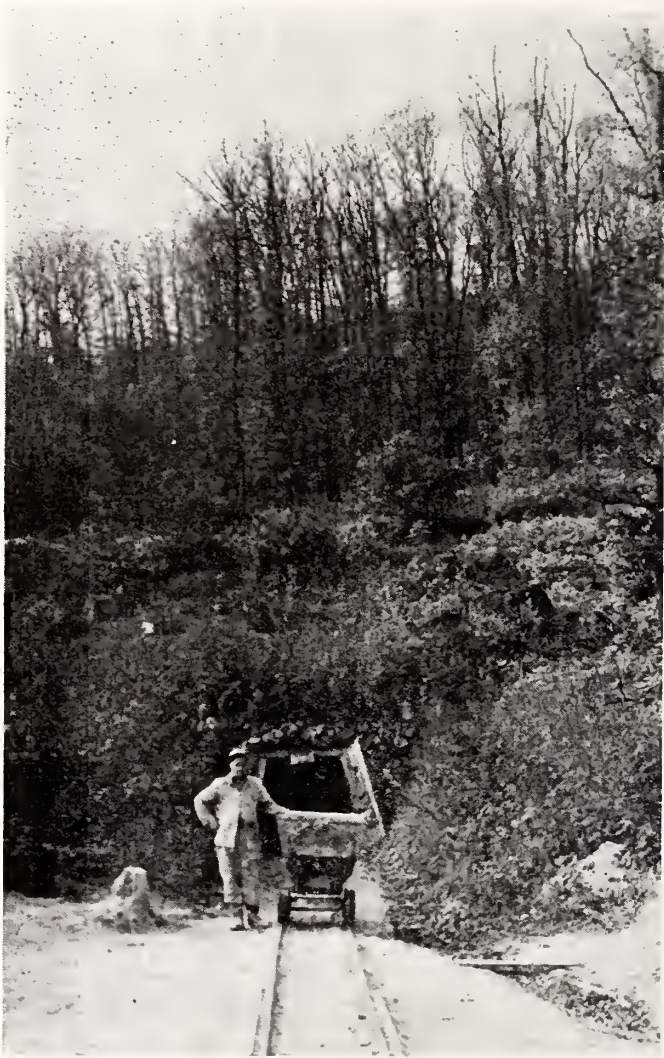
5. ábra. Az 1956-ban FRITS József által telepített Füzérradvány — Korom-hegyi Borai-táró bejárata. Innen ágazott el a több km hosszúságú, főként meddő kőzeteket feltáró vágatrendszer (DR. ZELENKA T. 1960. évi felvétele)
