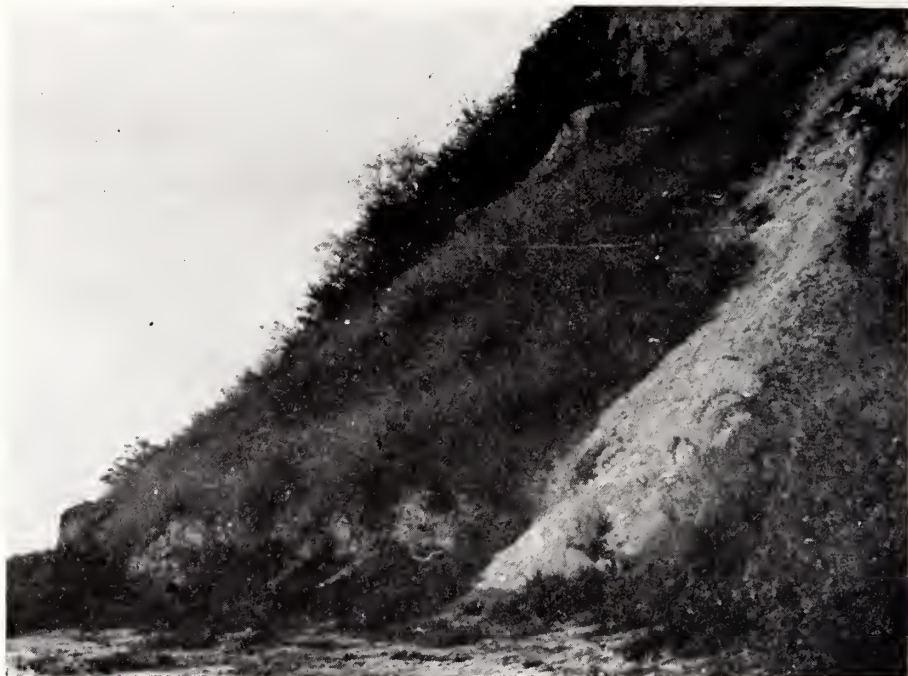
17. ábra. Ferdén íves csúszólappu mozgástípus Dunaföldvártól D-re Abb. 17. Bewegungstypus mit schräg gebogener Gleitfläche S von Dunaföldvár
