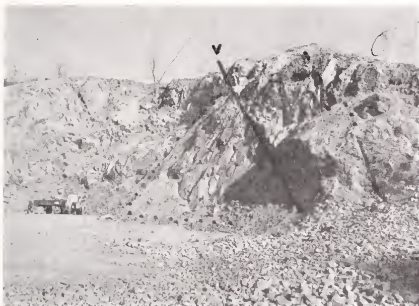
2. ábra. Medres-patak, ÉNy-i kőfejtő. A vetőzóna alatti részen található a molibdenit, az andezit elválási lapjai mentén Fig. 2. Northwestern quarry by Medres brook. Molybdenite occurs below the fault zone, along the places of jointing of the andesite
