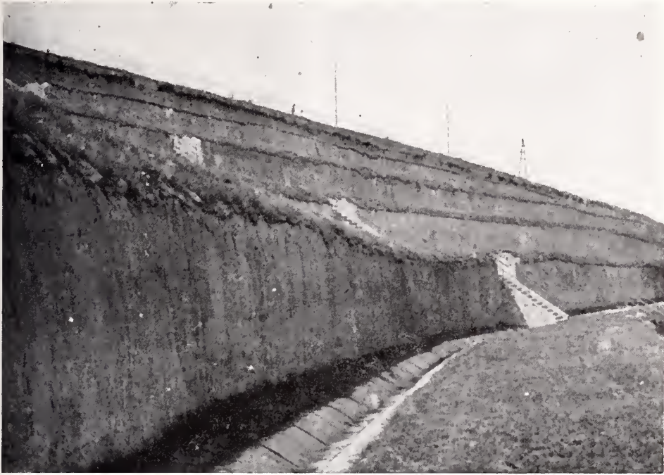
13. ábra. A rendezett és lelépcsőzött dunaiúvárosi magaspart Abb. 13. Das korrigierte und abgetrepte Hochufer von Dunaiúváros
