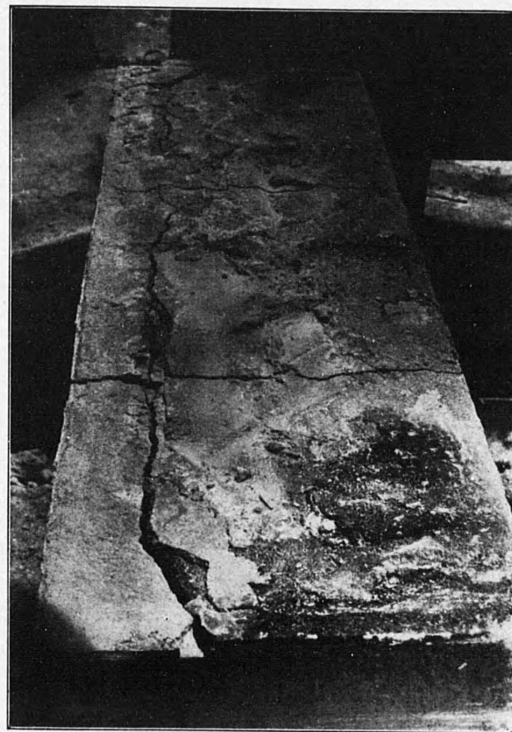
内面ノ剝離ト割レ折レノ狀況 (附 概 圖)
