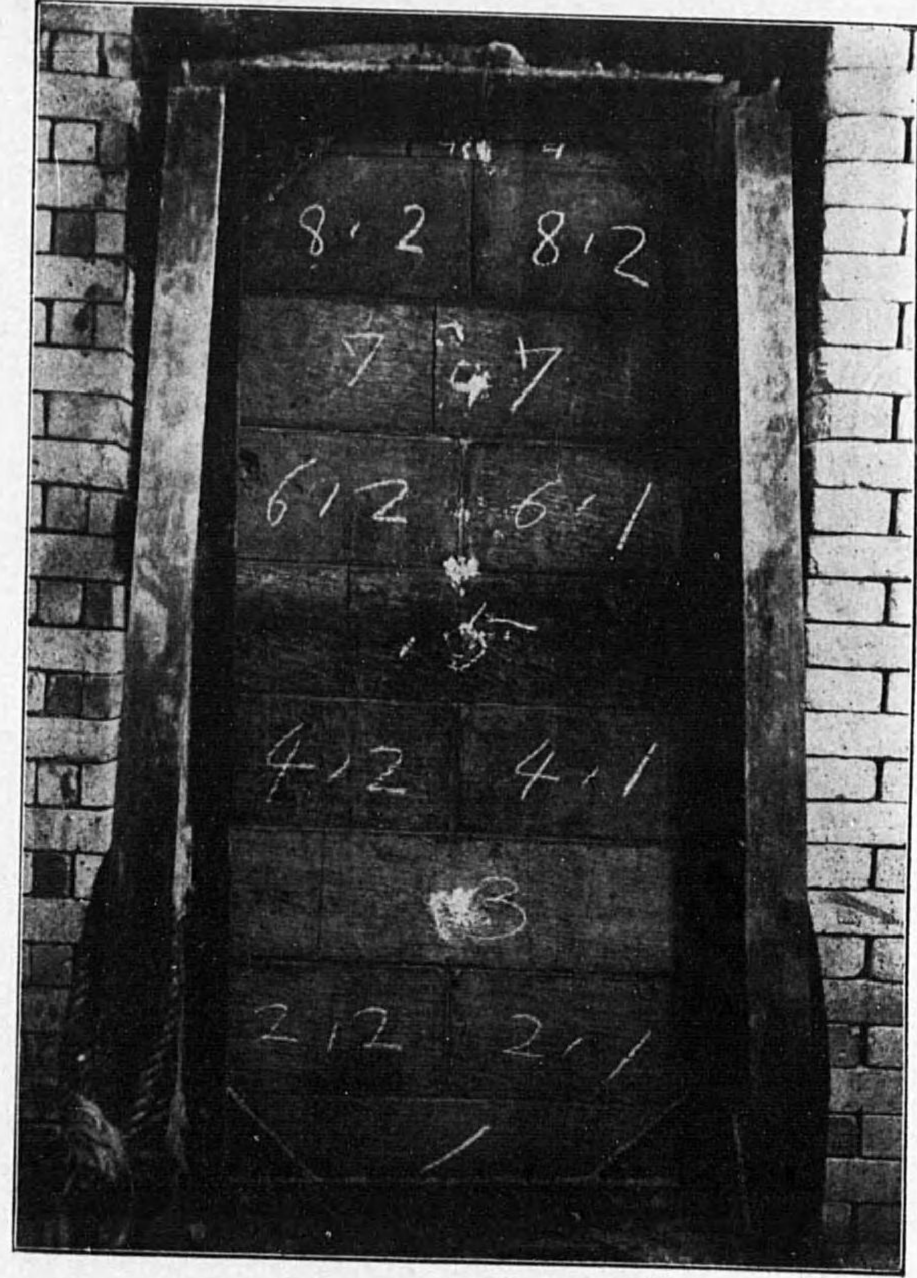
加熱試驗終了後注水前ノ外面
