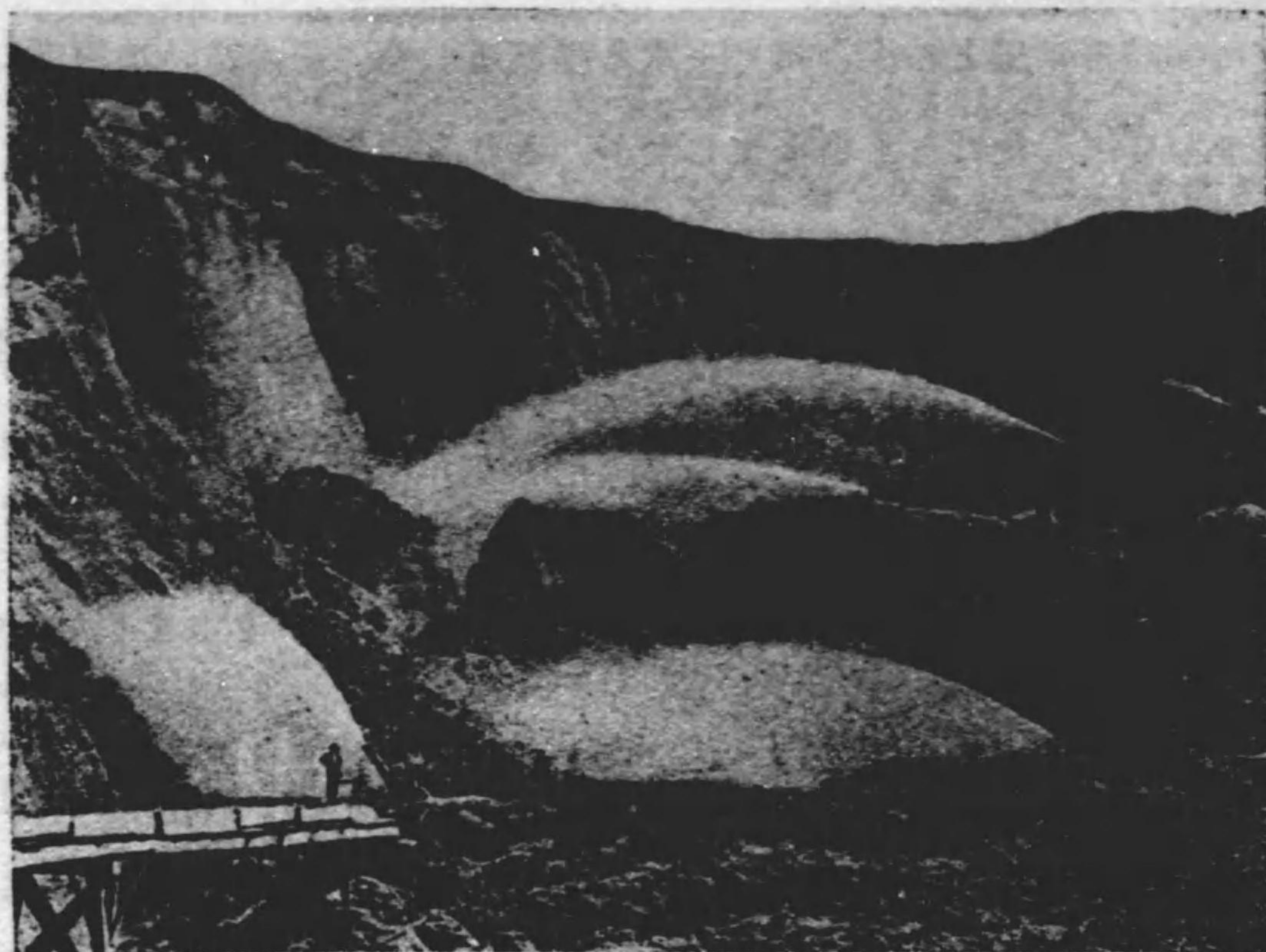
水蒸気による露出金鑛の碎落
