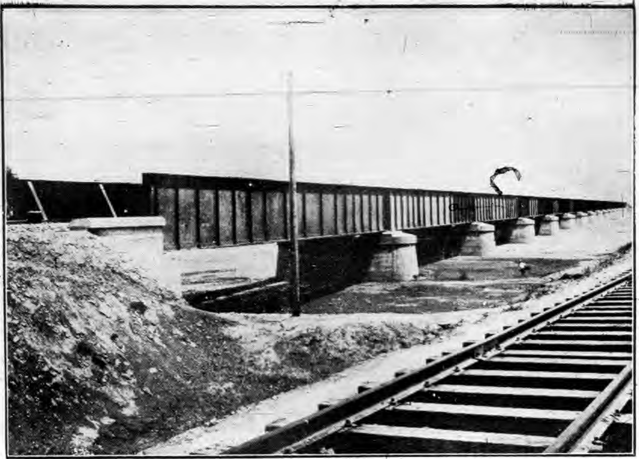
隴海路西潼段灃河六十孔廿五尺鋼梁橋側面
