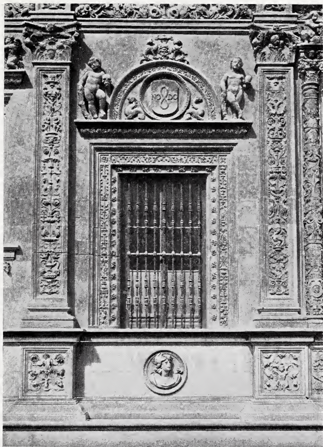
CASAS CAPITULARES. MAISONS CAPITULAIRES. DETALLE DE LA FACHADA PRINCIPAL DÉTAIL DE LA FAÇADE PRINCIPALE THE CHAPTER HOUSE. DETAIL OF PRINCIPAL FAÇADE
