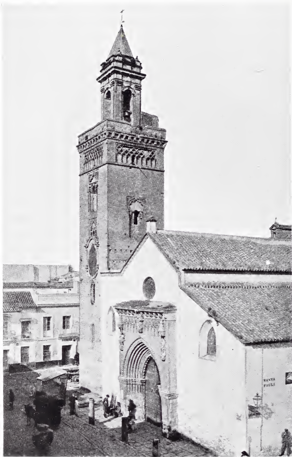
TORRE Y FACHADA DE SAN MARCOS
