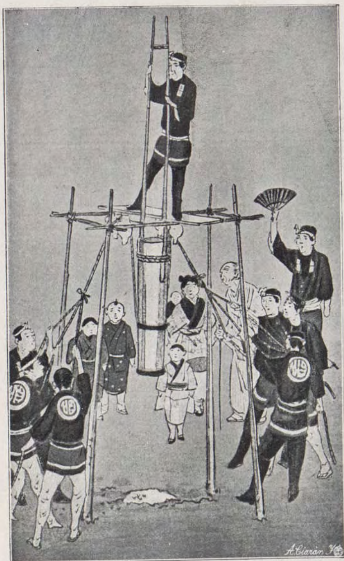
Obreros japoneses de construcción encajando una piedra. Tomado de Nippom Gakasu, «Titelbild.»
