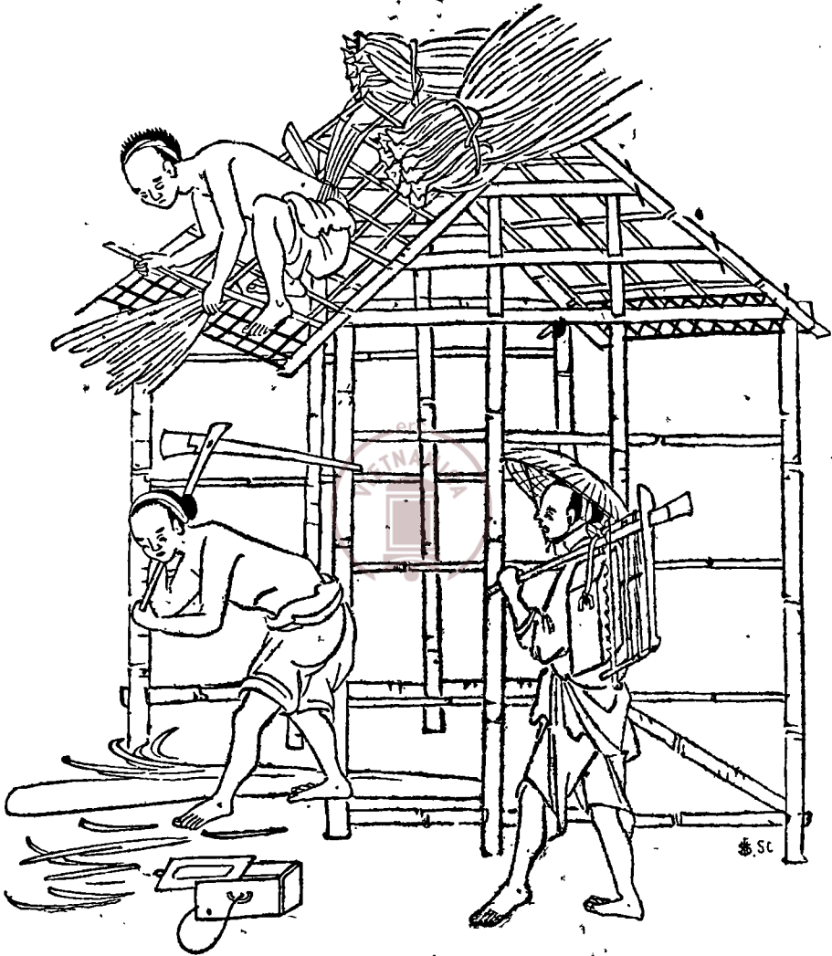
Fig. 36. — COUVREURS ET CHARPENTIERS
