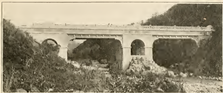
UN PUENTE DE HORMIGÓN ARMADO
