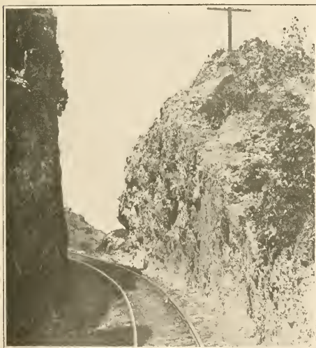
EL FERROCARRIL DE CIRCUNVALACIÓN Se principiaron las obras en 1888
