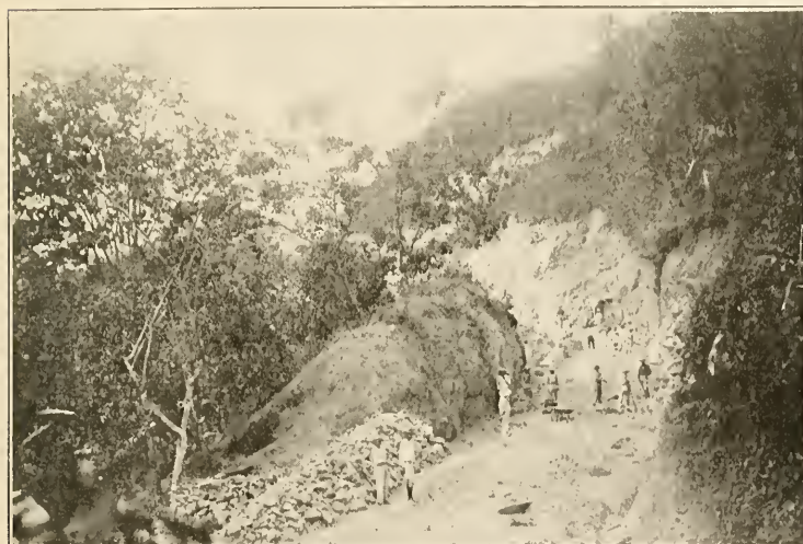
UNA CARRETERA EN CONSTRUCCIÓN El Pueblo de Puerto Rico continúa el trabajo de convertir los caminos vecinales en carreteras anchas y sólidas
