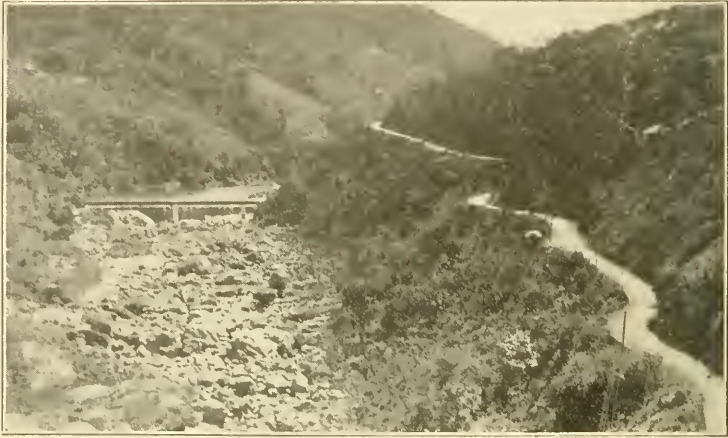
ACTUAL CARRETERA DE BAYAMÓN A COMERÍO
