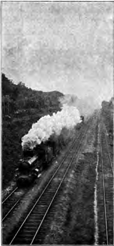
Fig. 75. Bahneinschnitt im Stadtwalde zu Frankfurt a. M.
