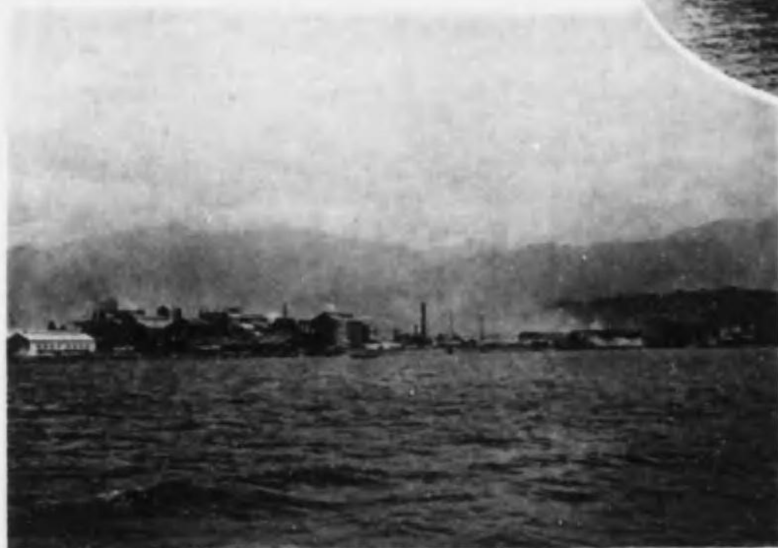
新居濱製造所全景
