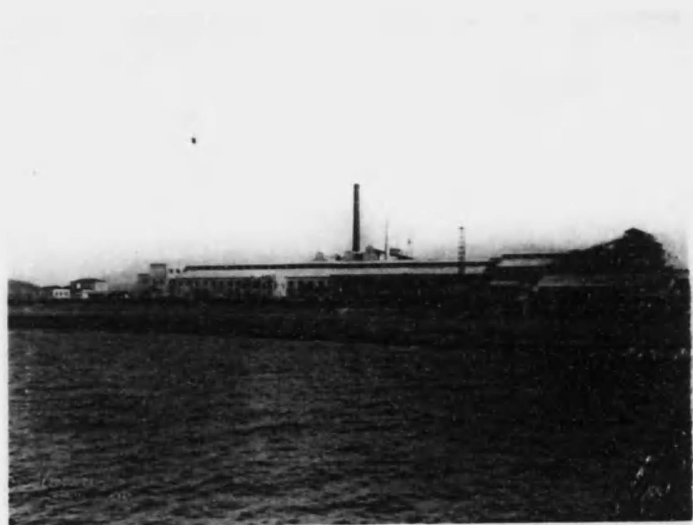
工場全景(西北面)
