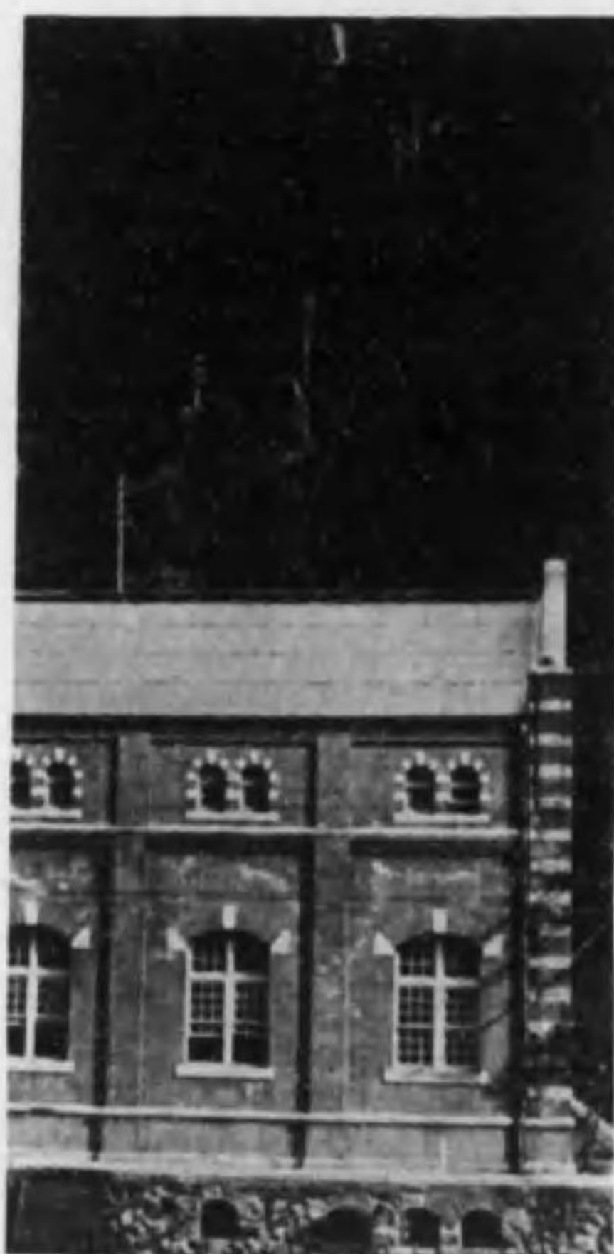
端出場發電所
