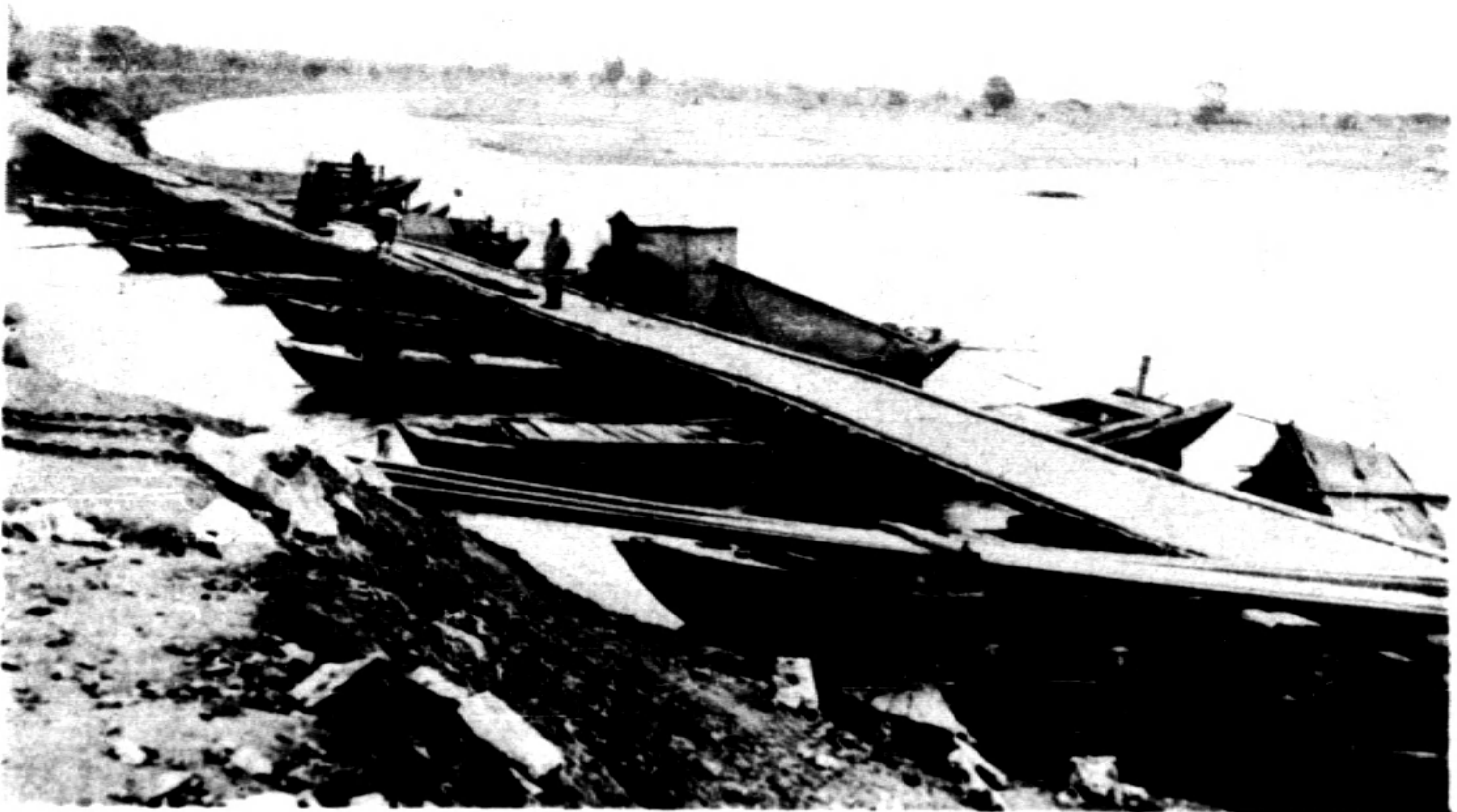
(照片四) 浮橋情形
