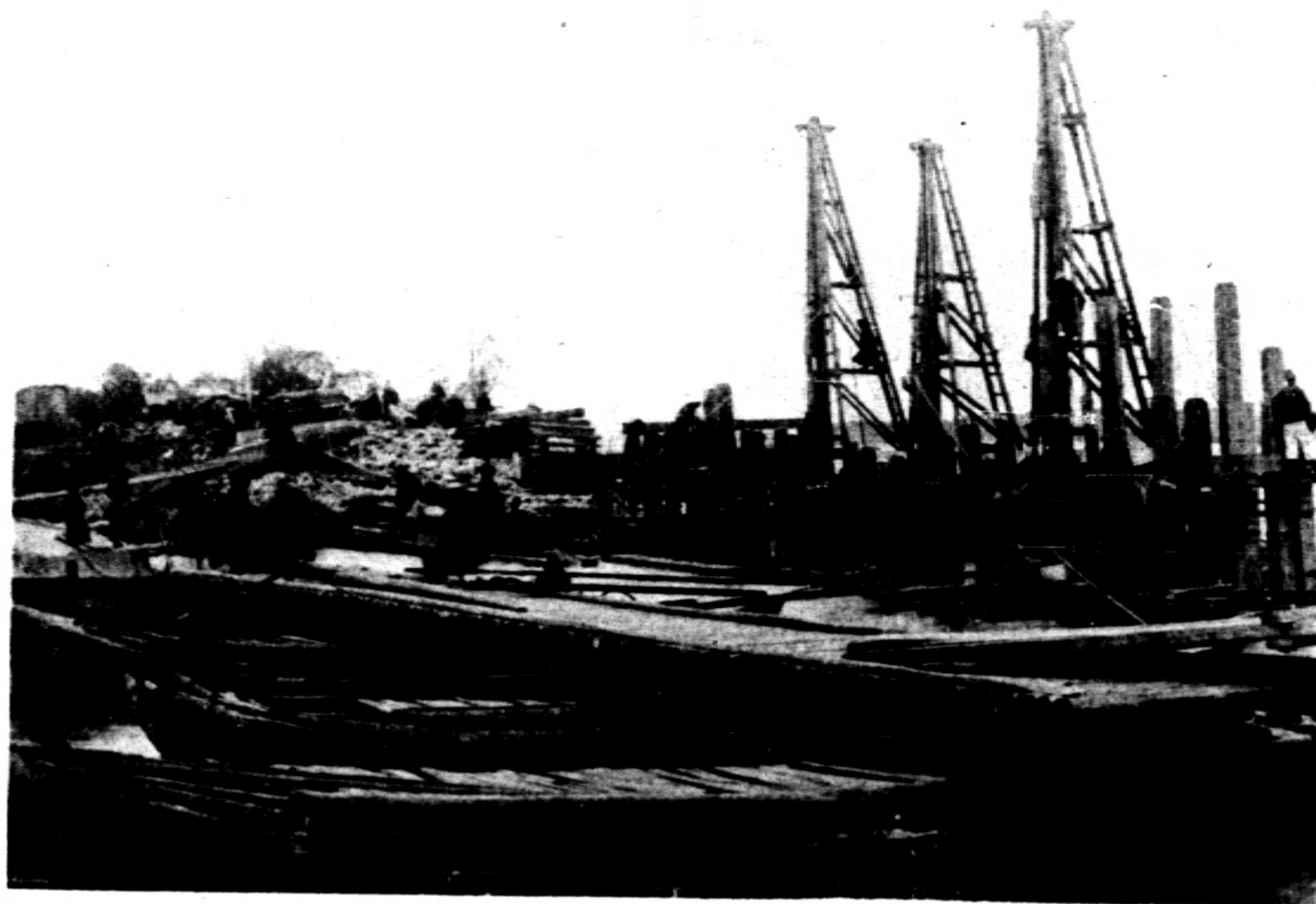
(照片二) 決口中部打樁情形
