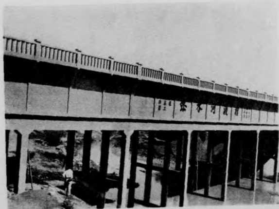
渡槽完工後側面圖
