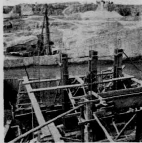
渡槽柱構木型工程
