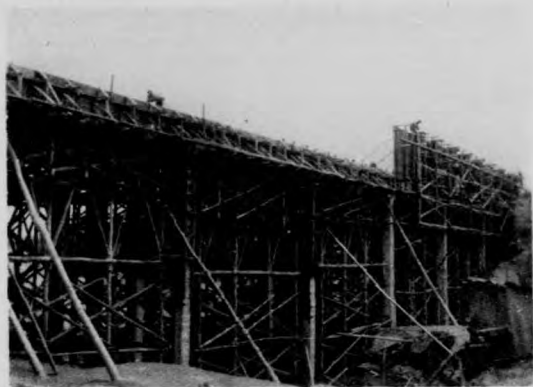
渡槽下部工程完工
