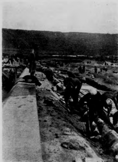
攔河大壩壩面砌塊石工程之二
