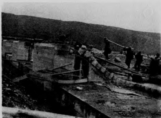
攔河大壩面砌塊石工程之一
