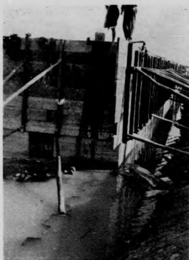
攔河大壩混凝土工程尚能見水面下鋼板橋頂
