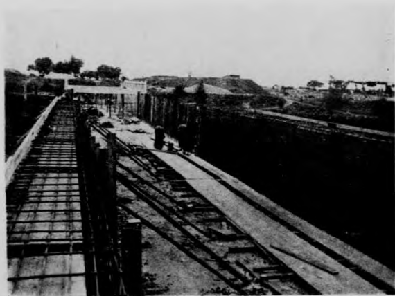
渡槽上部钢筋混凝土工程
