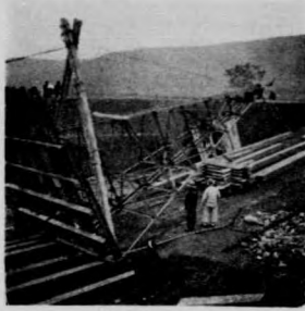
架橋打鋼置裝基開水引
