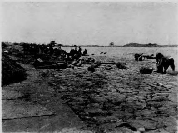
掘鉛絲籠片石工程
