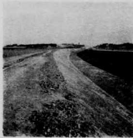
張堡村土渠工程之一段
