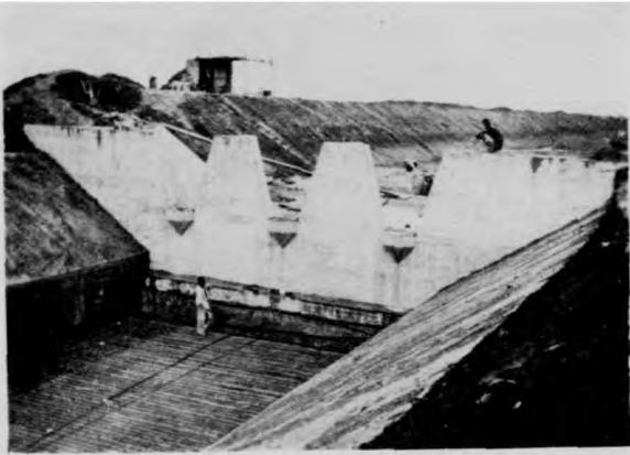
程工底鋪土凝混筋鋼水跌號一第莊家陳
