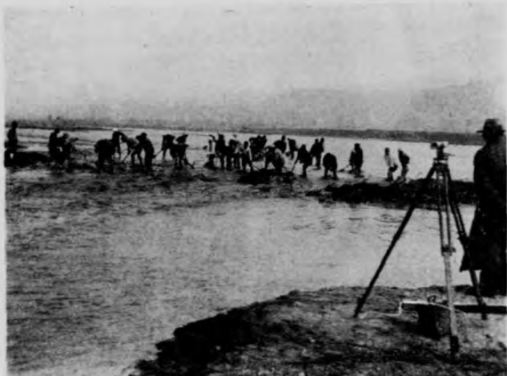
挖掘引河頭起時情形
