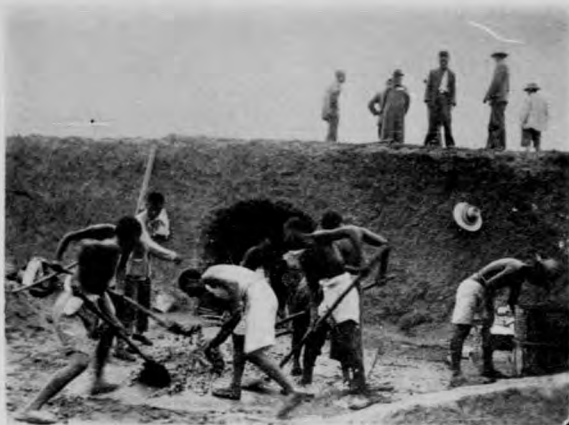
蔡劉村第三號跌水鋼筋混凝土工程之一
