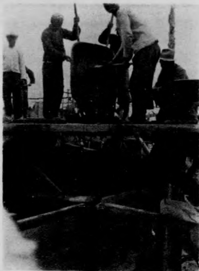
引水閘墩座基頂層混凝土工程
