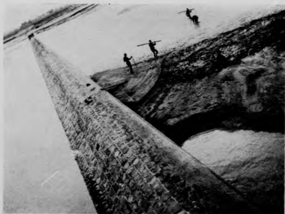
工完部全壩大河擱
