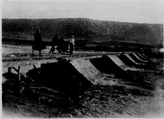
段南壩大河攔 用之水排時口堵壩水擋備處六口水排留預
