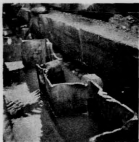
閘河大壩南段 鋼板樁工程行將告竣
