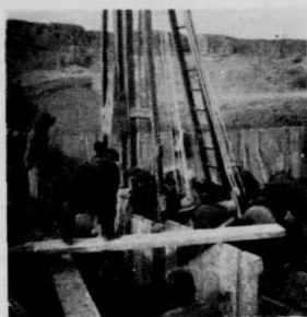
渡槽基打板桩工程
