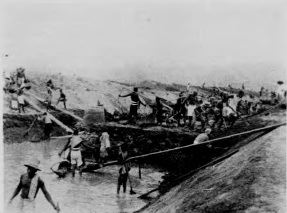
形情作工河引南掘挖
