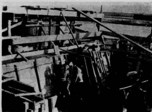
引水閘墩座後完工工程
