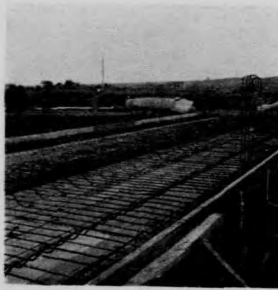
農校第三十一號 鋼筋混凝土橋 橋面鋼筋之排列
