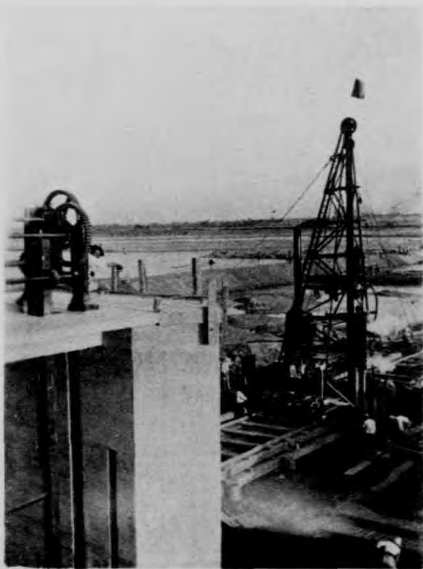
攔河大壩北段鋼板樁工程告竣
