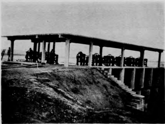
引水冲刷二閘鋼筋混凝土罩棚完工程成
