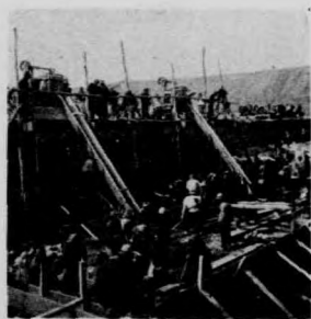
閘河大壩工程 混凝土拌合機工作情形
