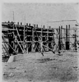
開二刷冲水引 竣完將行程工土凝混
