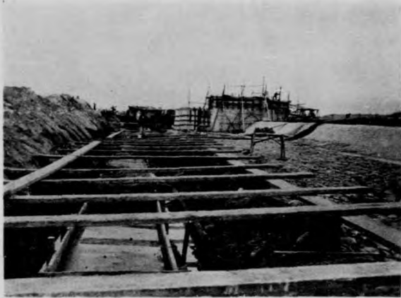
攔河大壩址基混凝土橫梁工程
