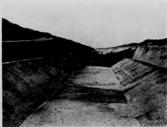
白家村第一渠土工將完竣
