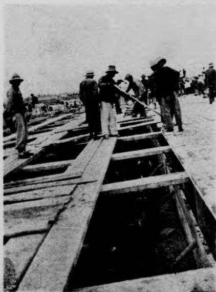
攔河大壩北段幕壩腳混凝土工作情形
