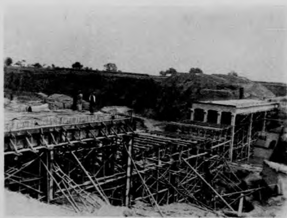
渡槽及柱梁工程完成三分之二
