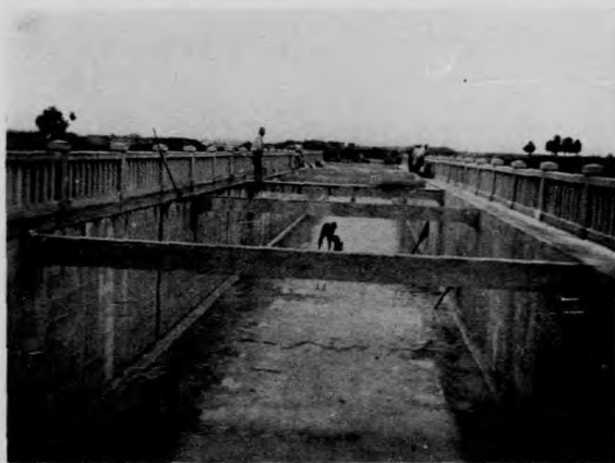
渡槽下部工程復刷漿工程
