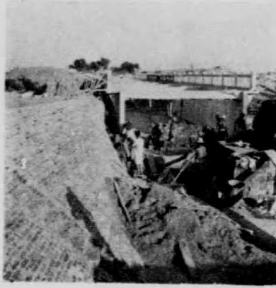
渡槽東端砌磚護岸工程
