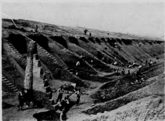
常興鎮第一渠挖土情形
