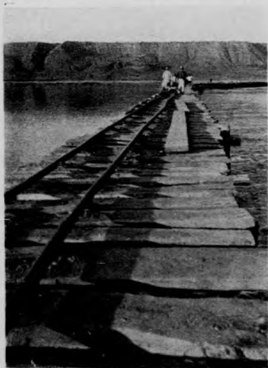
掘河大壩南夾河架橋築擋水壩
