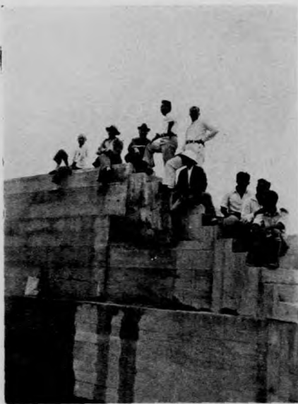
攔河大壩南翼牆工程告竣
