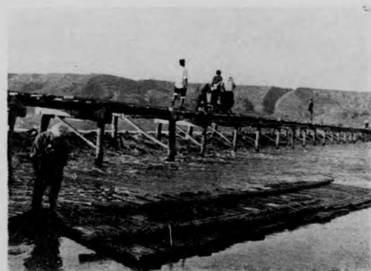
攔大河壩南夾河搖水壩堵口後閉氣工作
