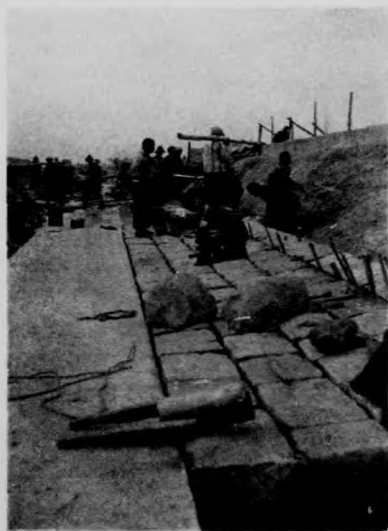
攔河大壩壩脚砌塊石工程
