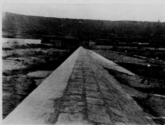
掘大河壩北段完工
