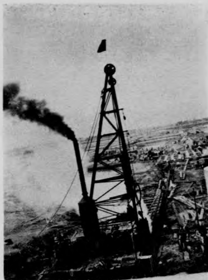
攔河大壩北段擋水壩堵口後打鋼板樁情形
