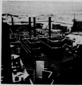
引水冲刷二间墩座第一层混凝土情形
