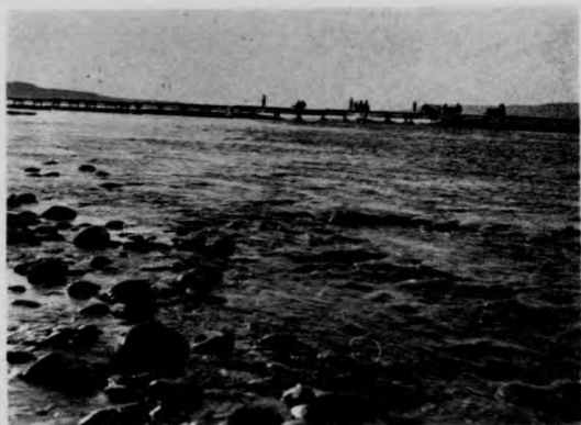
攔大河壩南夾河搖水壩堵口情形
