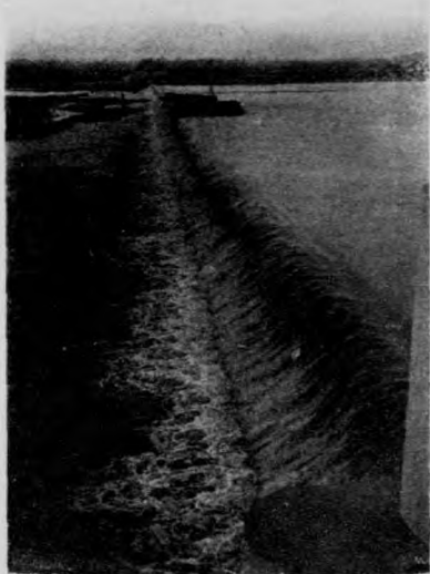
掘河大壩滾水情形
