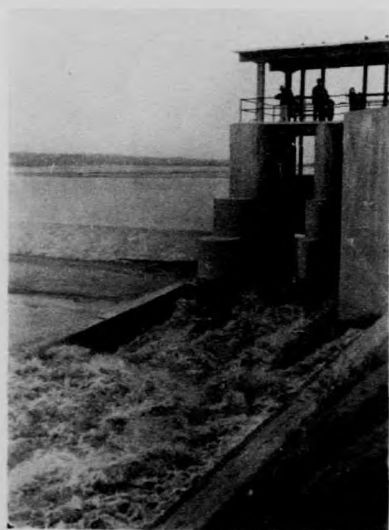
冲刷二閘放水情形
