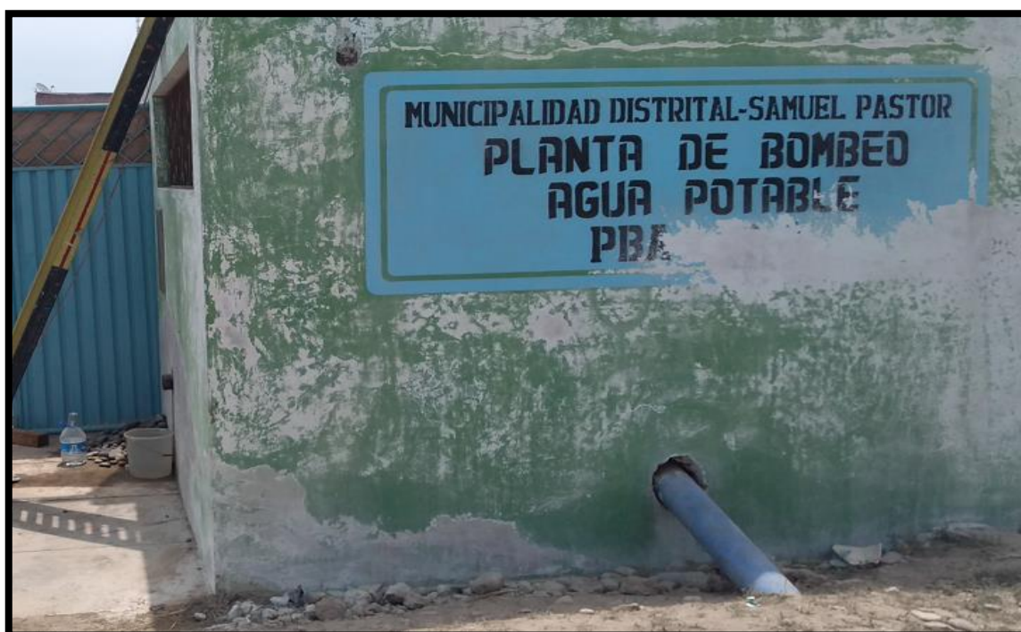
Anexo 28. Fotografía de ubicación de pozo de agua (inventario de Notas de agua)
