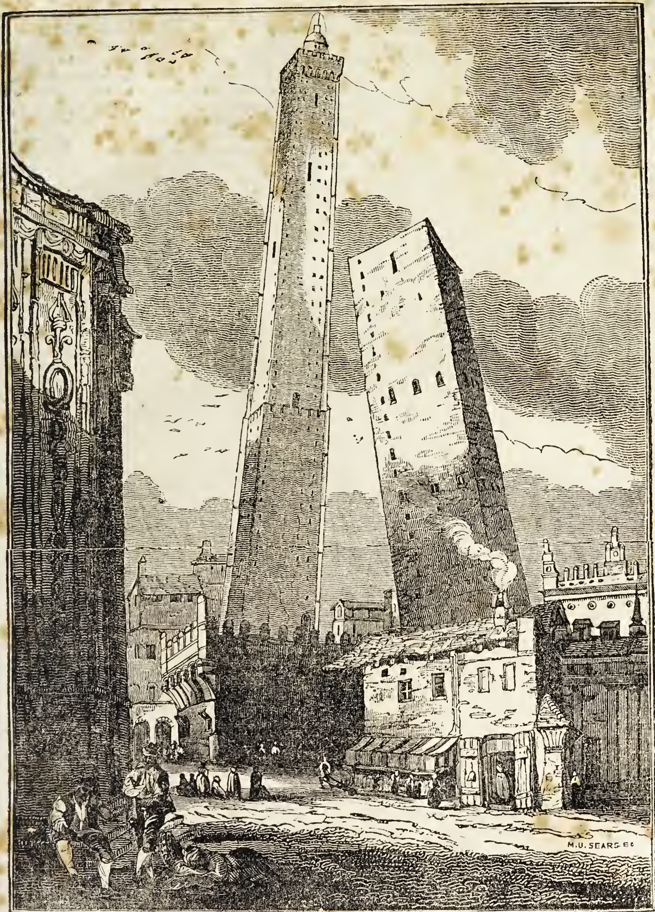
( Torre degli Asinelli. — Torre Garisenda )
