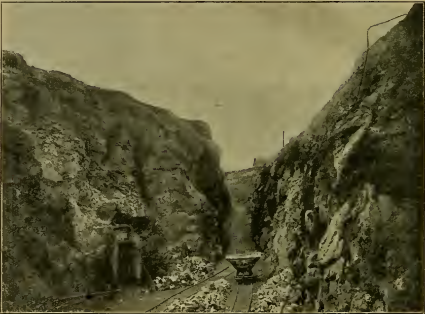
Fig. 12. Ansicht des unteren Kalksteinbruches in Polgárdi im November 1910.
