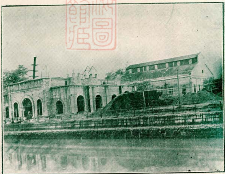
舊廠低壓煤汽抽水機房
