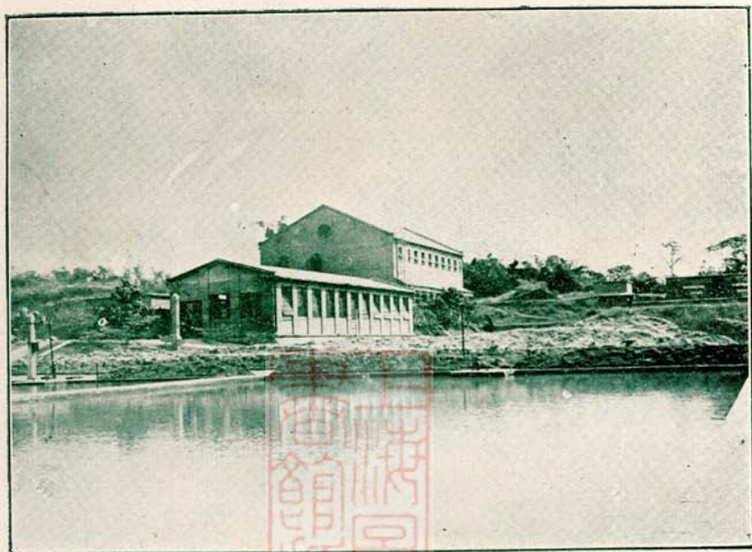
新水廠高壓抽水機及發電機房外觀
