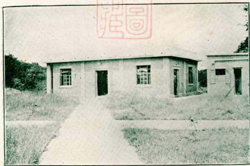
新廠低壓抽水機室
