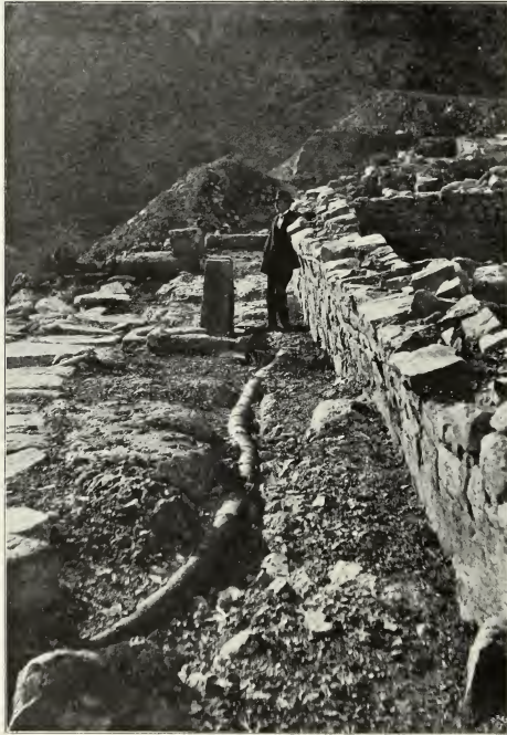
Abb. 41. Zuleitung des Laufbrunnens in der Quellenthorstrasse.
