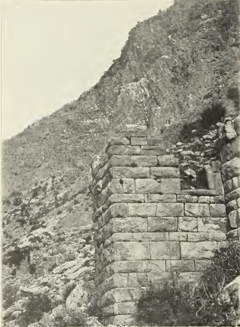
Abb. 24. Stadtmauerturm nördlich des Westthores.
