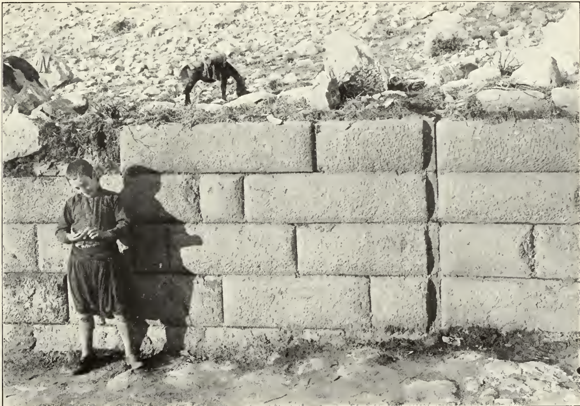
Abb. 319. Ostende der Quaderfront des Hauses westlich von Haus Nr. XXXIII.
