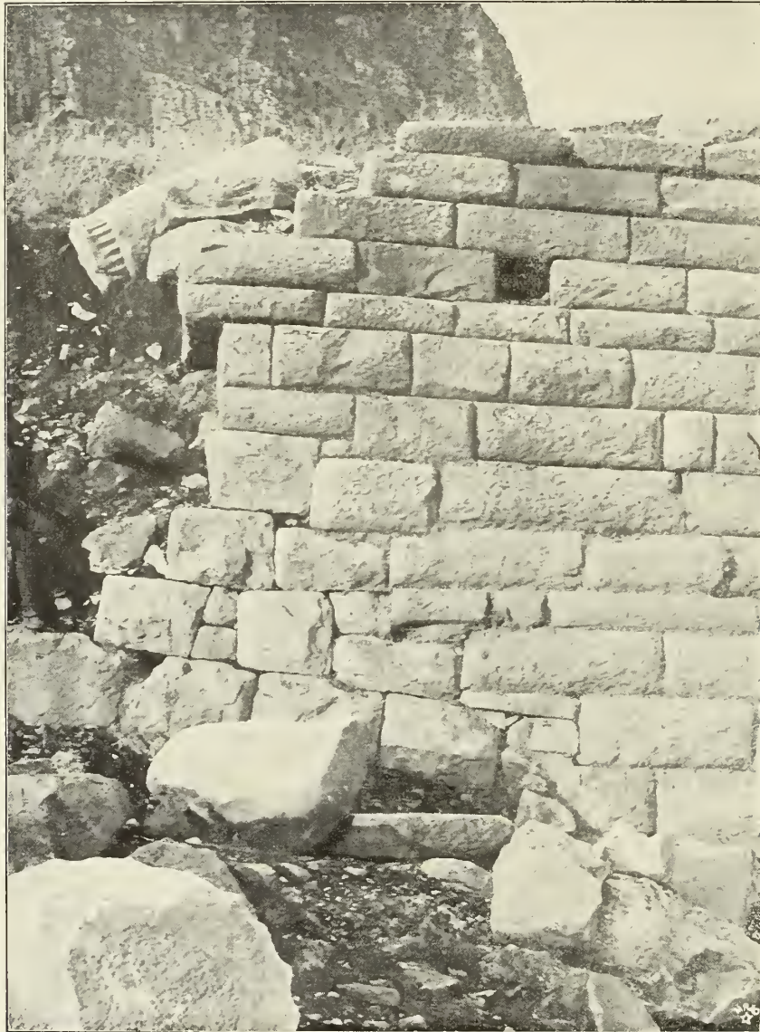
Abb. 99. Stützmauer der Terrasse des Athenaheiligtums.
