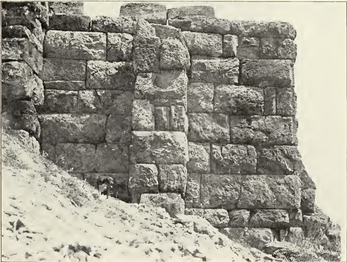
Abb. 30. Stützmauer des unteren Gymnasien.
