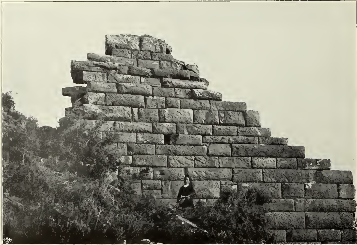
Abb. 26. Akropolismauer im Südwesten.
