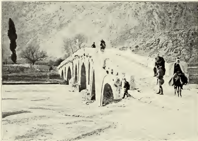
Abb. 18. Maeanderbrücke bei Kemer.
