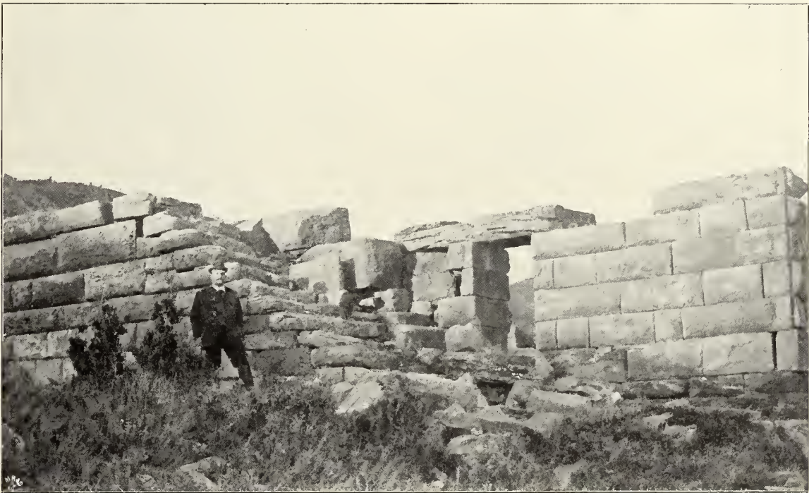
Abb. 27. Akropolismauer, Innenseite mit Turmeingang und Treppe zum Wehgang.
