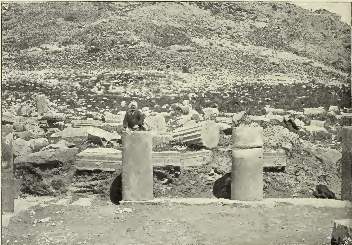
Abb. 182. Säulenstümpfe und Simablöcke der Osthalle des Marktes.
