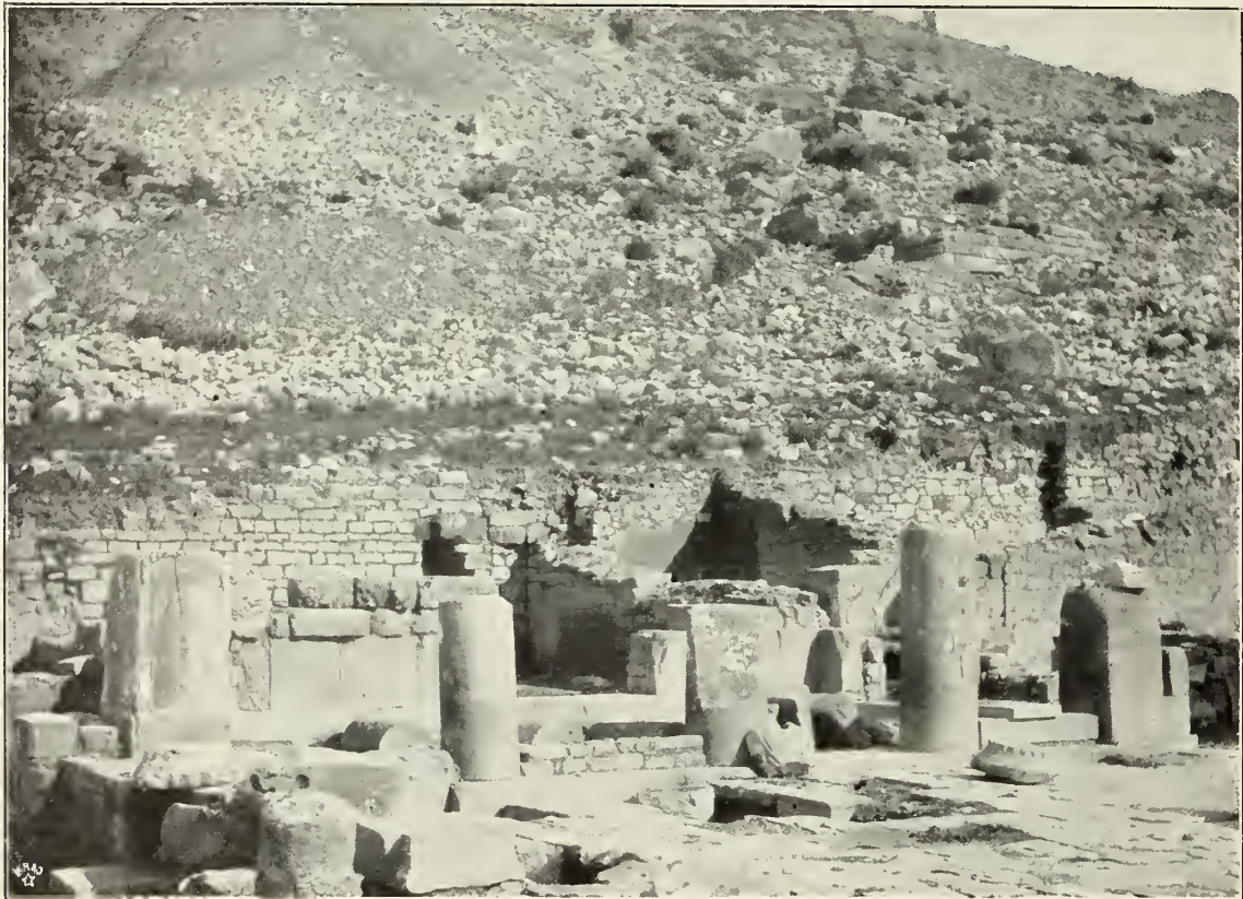
Abb. 317. Die Prosta des Hauses Nr. XXXIII im jetzigen Zustande.
