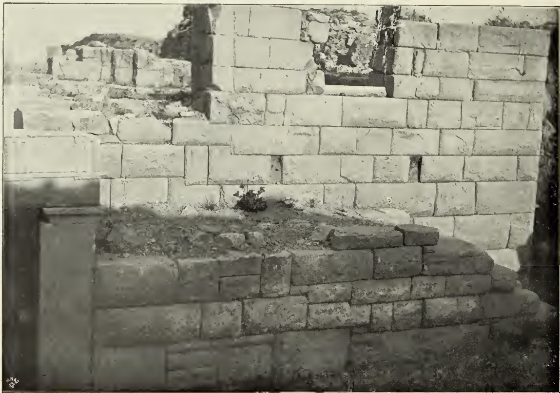
Abb. 241. Westseite des Bühnengebäudes.
