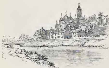
No. 34.—Cathedral, Périgueux.
