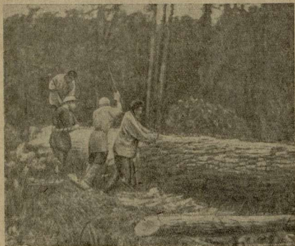
Снятие коры с болванки для лодки.
