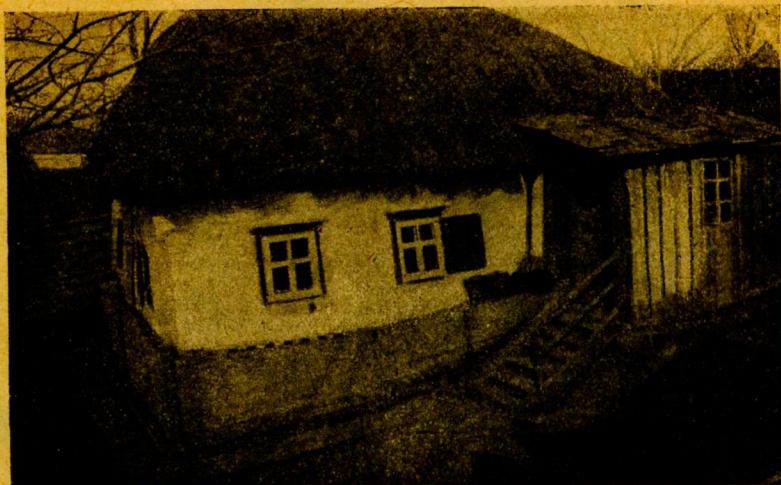
№39. Хата по Ночліжній вул., ч. 8, в Харківі.
