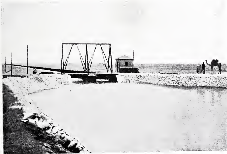
SERBATOIO E PORTE.
