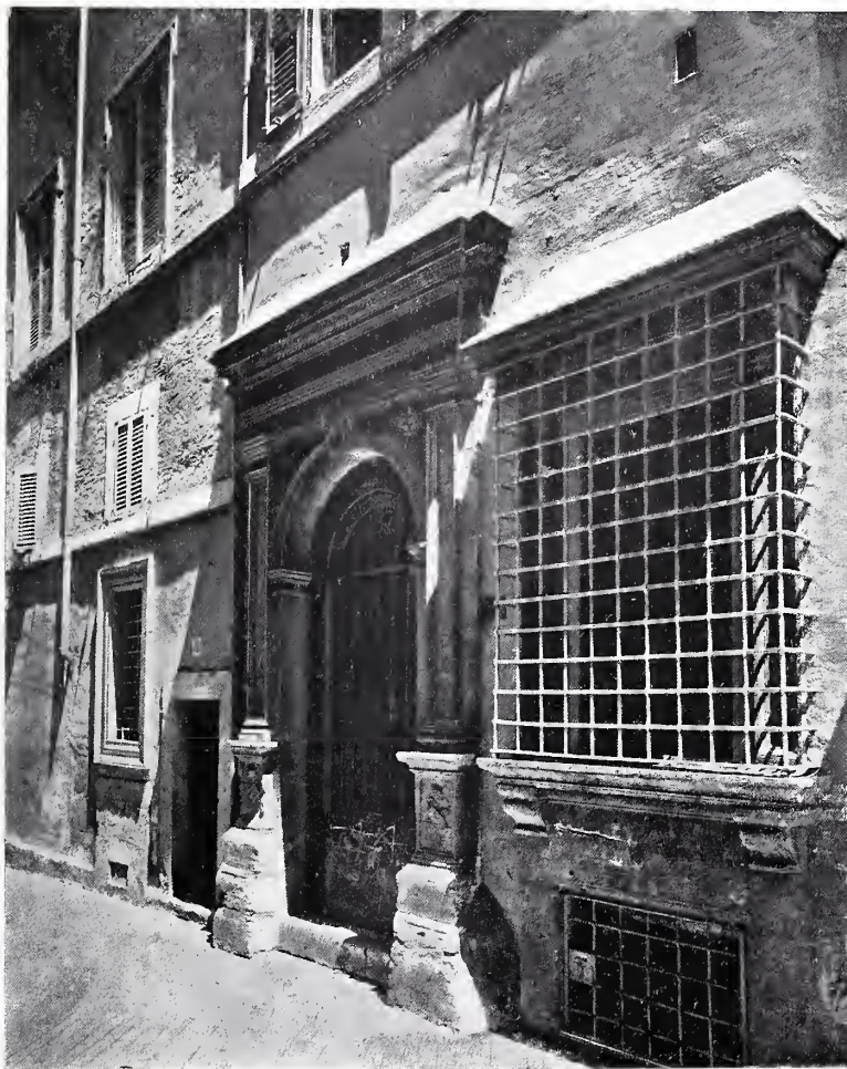
ROMA — CASA IN VIA DEI VENTI.
