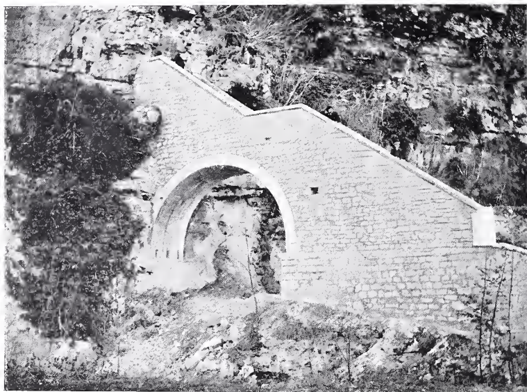
IL NUOVO PONTE D'ACCESSO ALLA CHIESA DI S. MARCO.
