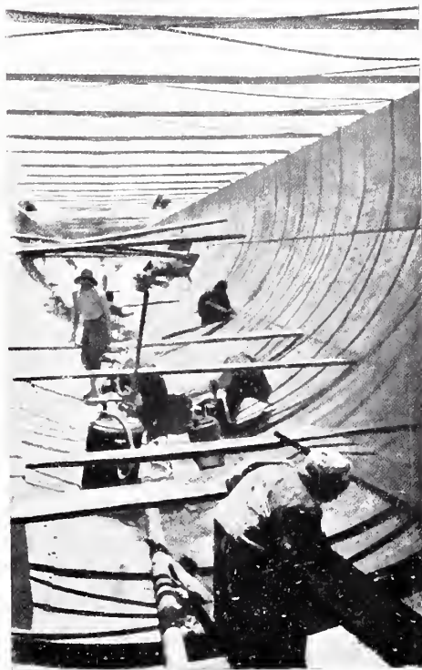
CHIODATORI AL LAVORO NELL'INTERNO DELLA CONDUTTURE D'ACCIAIO.
