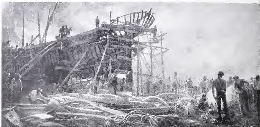
PLINIO NOMELLINI — IL CANTIERE.
