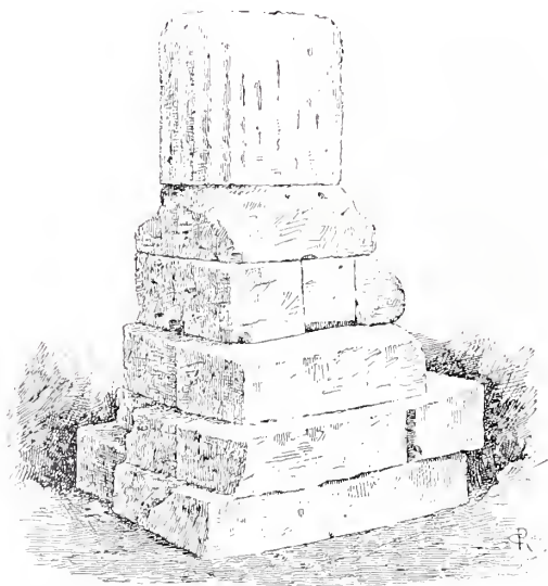
TEMPIO DEL « MULINO A VENTO » — PARTICOLARE DELLO STILOBATE.
