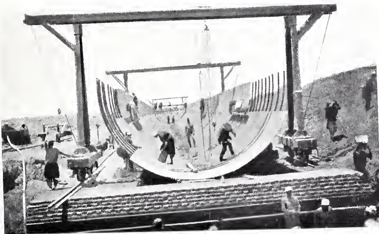
EREZIONE DELL'ULTIMA SEZIONE DEL CONDOTTO D'ACCIAIO.
