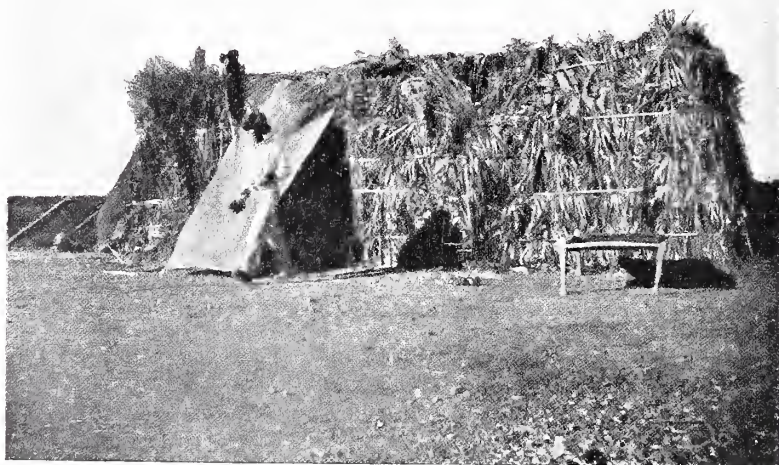
QUARTIERE DELL'INGEGNERE IN CAPO DURANTE IL LAVORO D'IMPIANTO.
