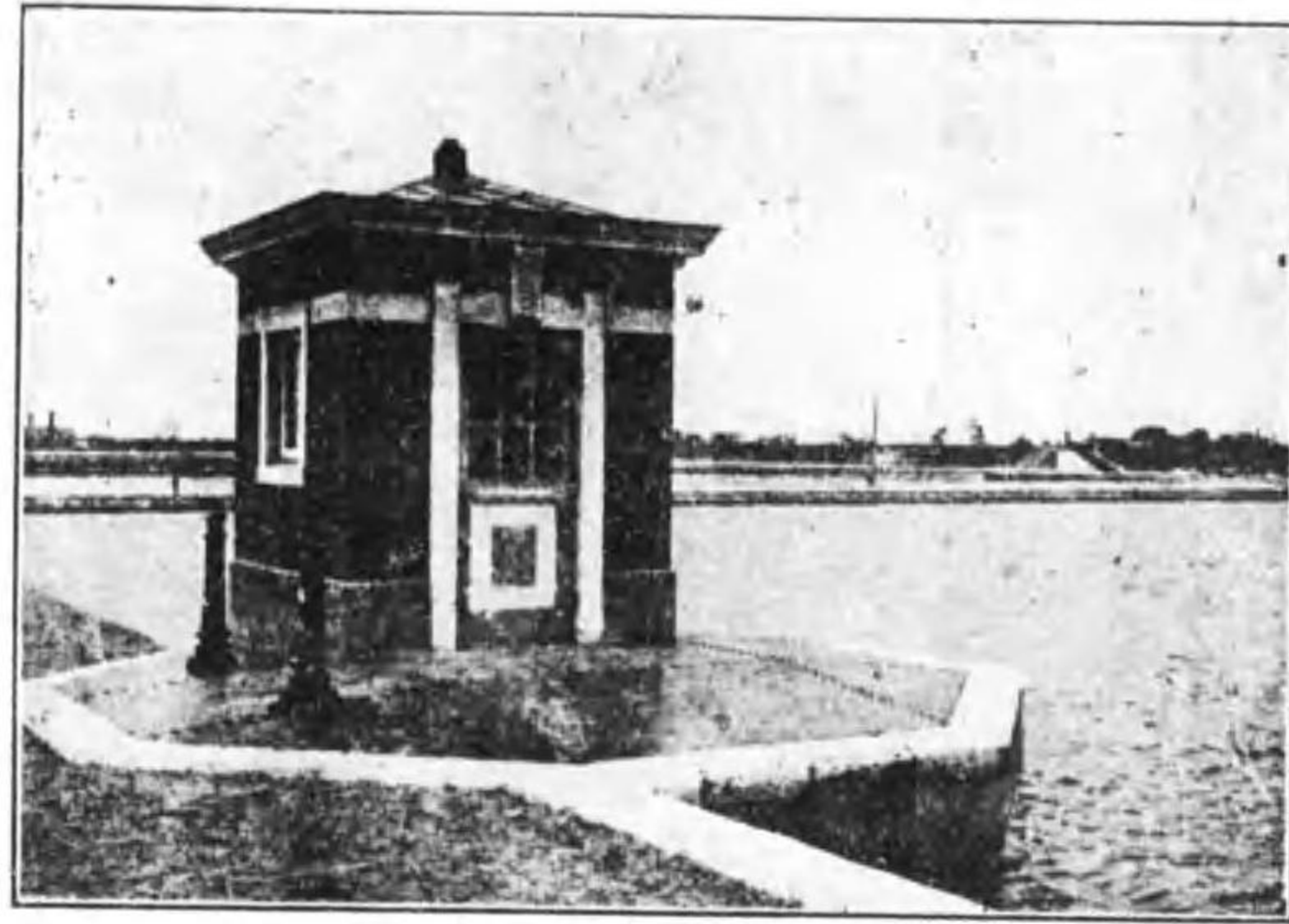
第二十六圖 大阪市水道濾過池節制井上屋
