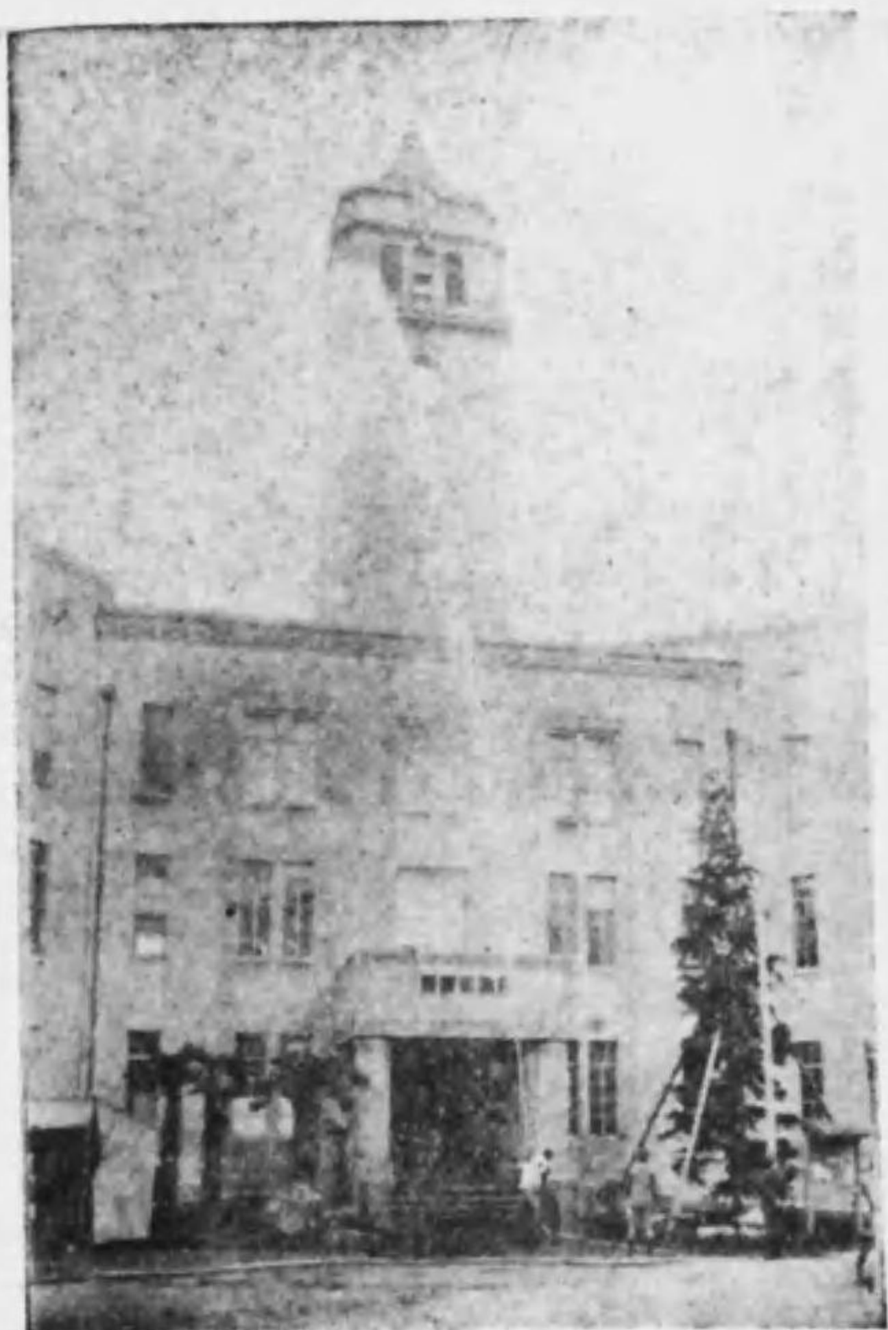
市役所前ニ於ケル消火栓水勢試験
