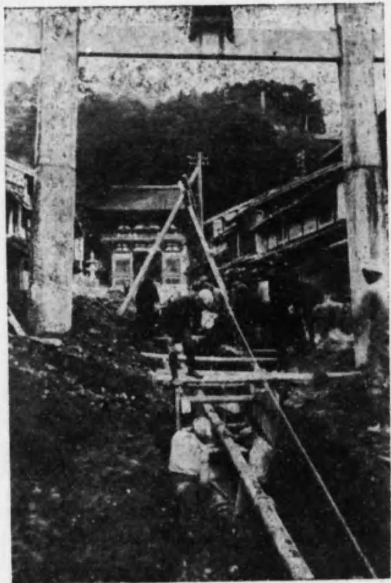
長等神社前ニ於ケル配水管布設工事
