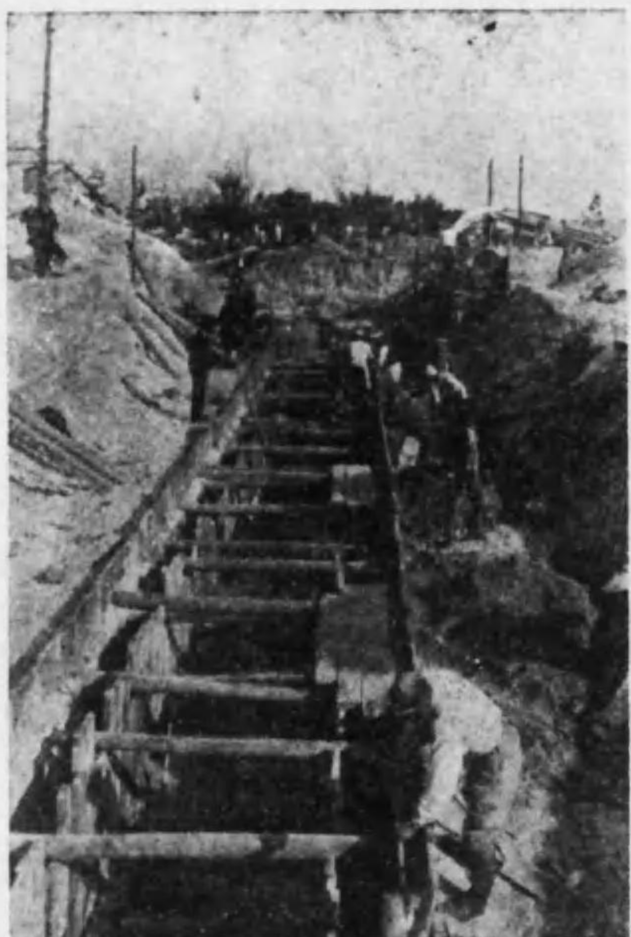
集水埋渠埋設工事
