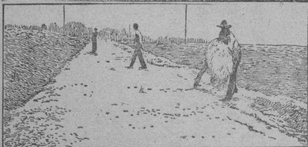
第三十七圖 馬卡丹式路築造法
