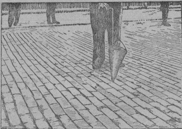
第五十一圖 用尖罐盛地氈青灌入磚路之縫
