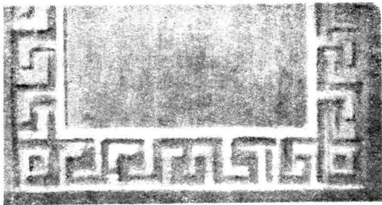
第十七圖 有花邊之三和土表面用酸類腐蝕
