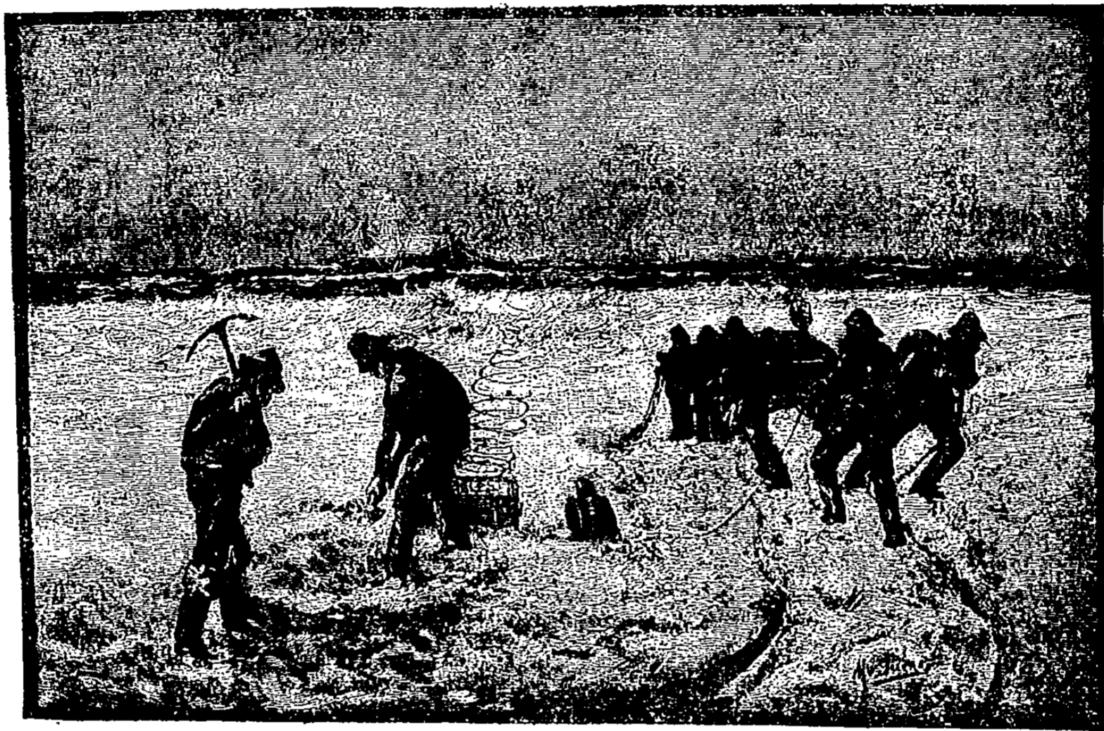
Pose d'un appareil de sauvetage.
