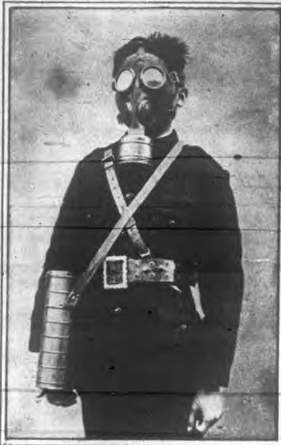
(右)意大利式之防毒面具——此乃橡皮所製成。鼻旁之圓形物上， 有無數小孔，乃出氣孔。內裝活瓣，使外部空氣，不能侵入。藥罐懸於 面具之下，與面具相連處，裝有進氣活瓣。因其所吸進之空氣，經過 藥罐過，不致有何危險。
