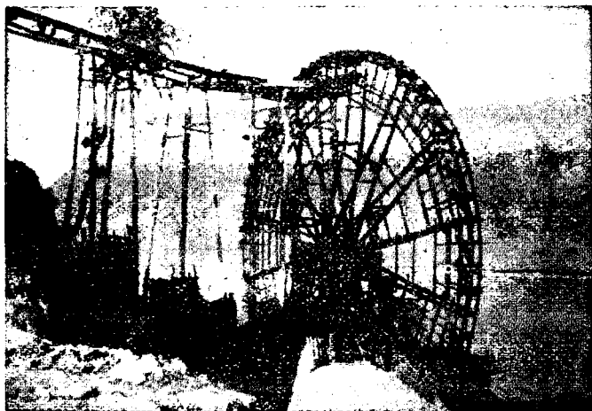
圖十六 黃河 沿岸的水車。水車轉到頂端自然會傾注於橫槽。圖中對岸岸壁可見田高於水的高度。
