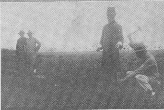
疏浚十里長溝之測量工作
