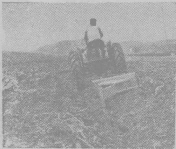
中林所用曳 引機開築水 土保持實驗 寬硬堤田情 形
