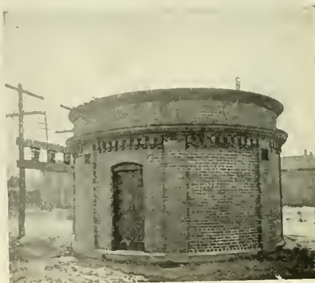
FIG. 1. ELECTRIC PUMP HOUSE, L. S. & M. S.
