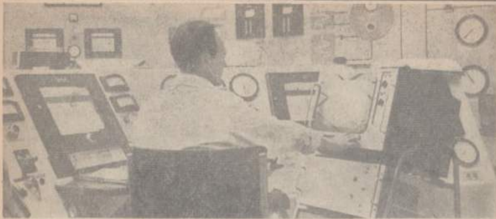
بوسیله این تلویزیون می توان انجام کلیه کارها را در درون و بیرون پیل مراقبت کرد.
