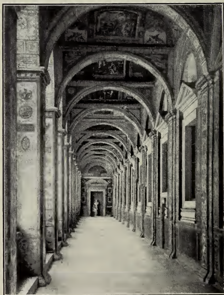
Ansicht der Loggien. Rom, Vatikan.
