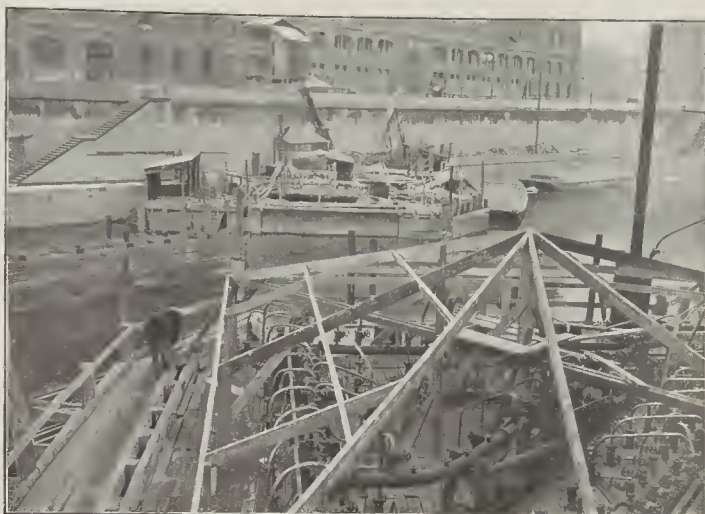
Vista general de las obras para consolidar el subsuelo fluvial, operación que se efectúa por medio de máquinas con motor de amoníaco que permiten perforar el suelo congelado
