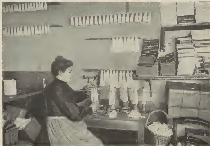
Fig. 2. - Operación de modelar los manguitos al calibre que se quiera
