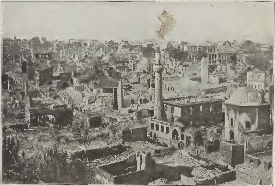
Estambul (Constantinopla).—Horroroso incendio ocurrido el día 23 de agosto último y á consecuencia del cual quedaron destruidos 2.000 edificios y sin albergue 20.000 personas. Aspecto de las ruinas después de la catástrofe (De fotografía de Harlinghe.)
