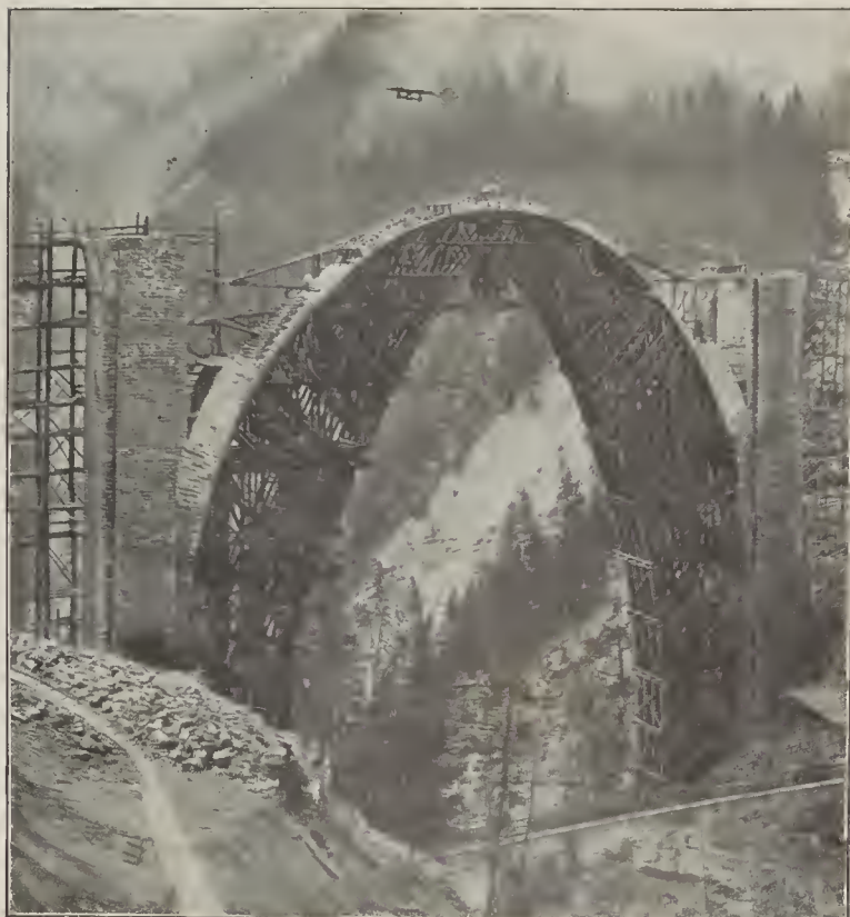
Una obra maestra de ingeniería.—El arco principal del viaducto de Wiesen, que actualmente se construye en el cañón de los Grisons (Suiza). (De fotografía de Trampus.)
