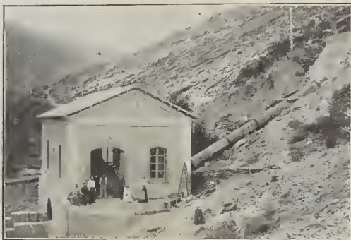
Central eléctrica de las minas
