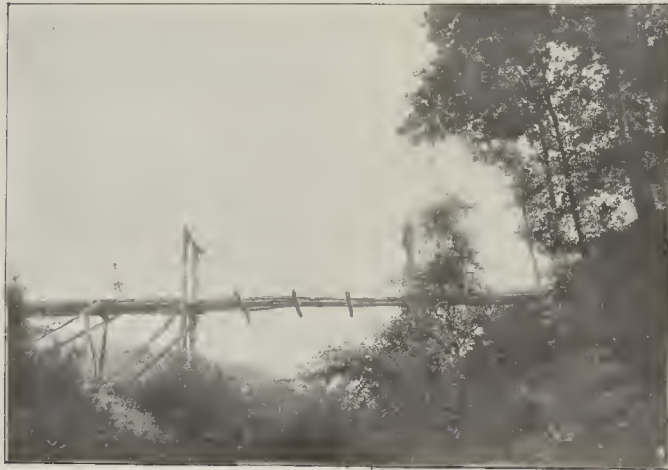
Construcción de un puente de troncos y ramas para salvar un barranco
