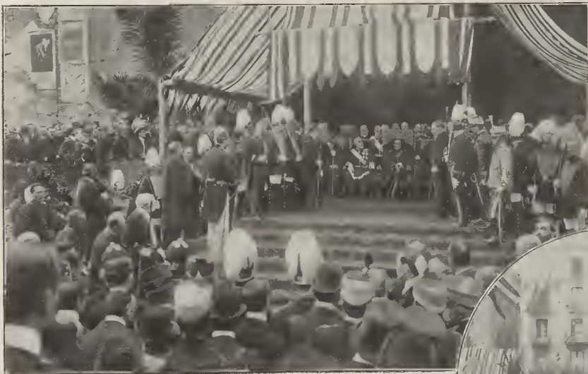
Tribuna regia levantada para la inauguración de las obras de la reforma
