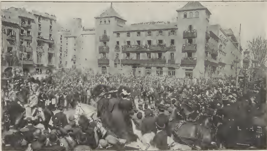
Llegada de S. M. al lugar destinado á la inauguración de las obras de la reforma interior de Barcelona
