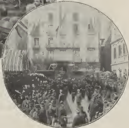
Primera casa que ha de derribarse y en la que se efectuó la ceremonia de hacer caer S. M. una piedra, inaugurando así las obras
