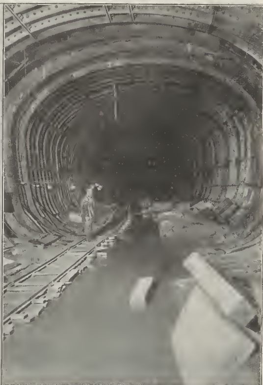
Vista de la armazón metálica del centro del túnel que pasa por debajo del Sena y que se compone de tres cajones que han sido sucesivamente introducidos en el lecho del río y después unidos entre sí. El agua que se ve en el grabado procede de la orilla derecha y será próximamente agotada.
