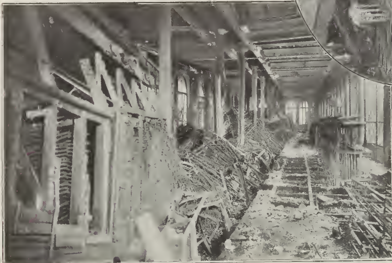
La batería americana tal como ha quedado después del incendio
