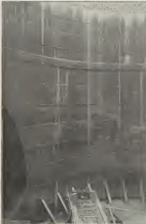
Vista interior de la obra de enlace entre la estación «La Cité» y el túnel que pasa por debajo del Sena. Esta obra, que servirá de entrada á la estación y contendrá las escaleras y los ascensores para el servicio de la misma, está situada á 20 metros debajo del suelo.
