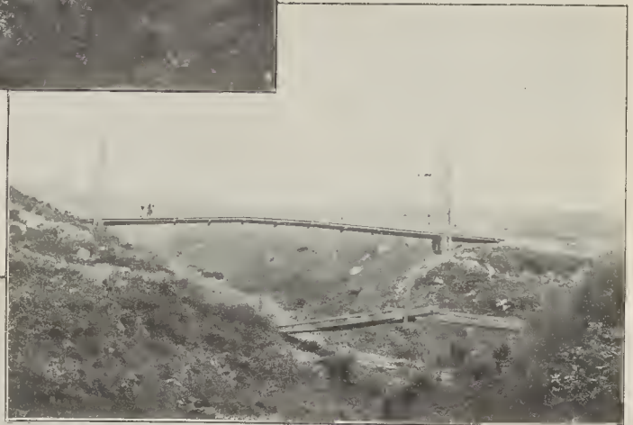
Puente colgante de 70 metros en el punto más elevado de un barranco
