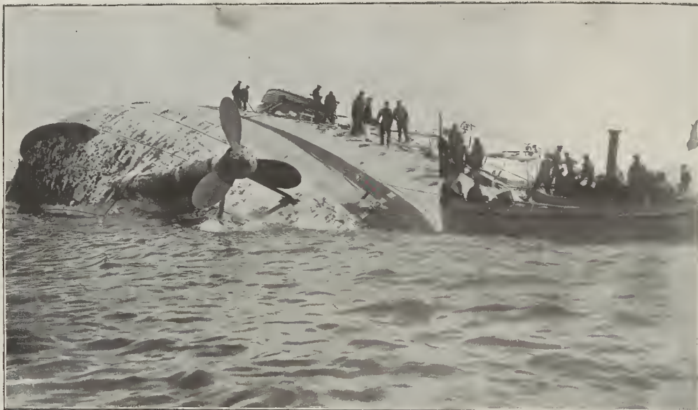
El crucero inglés «Gladiator» después de su choque con el transatlántico «Saint-Paul» en las aguas de Port-Victoria, junto á la isla de Wight (Inglaterra). (De fotografía de M. Rol y C.)
