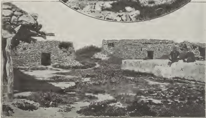
Cabo de Agua.—Fortaleza.—Cisterna (x) de 22 x 5 metros y de mucha profundidad, situada en el patio del santuario y cuya agua es sagrada para las tribus de Quebdana. (De fotografías del capitán D. M. Lorduy.)
