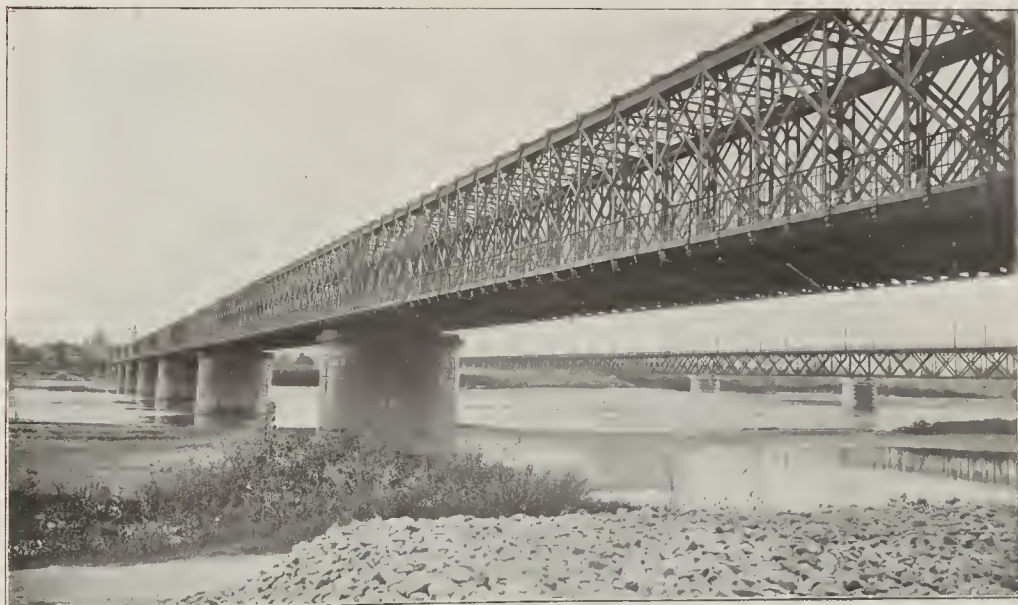
Vista del nuevo puente sobre el Po, recientemente inaugurado por el rey Víctor Manuel III La longitud del puente con los viaductos, terraplenes, etc., es de 1.743 metros; la anchura del tramo metálico, de 15, y el coste total, de 4 millones de liras (De fotografías de Lucas Comerio, comunicadas por Carlos Trampus.)
