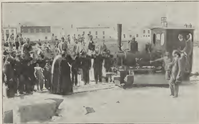
Arrecife de Lanzarote (Canarias) Bendición de la locomotora destinada á las obras del puerto
