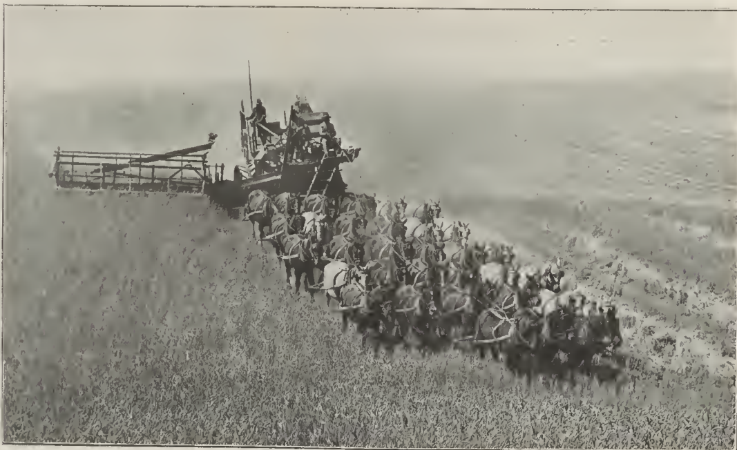
Máquina agrícola que se emplea en los Estados Unidos, tirada por treinta y tres caballerías, que siega, trilla, mete en sacos el grano y forma gavillas con la paja, colocándolas en hileras. (De fotografía de Underwood et Underwood, N. Y.)
