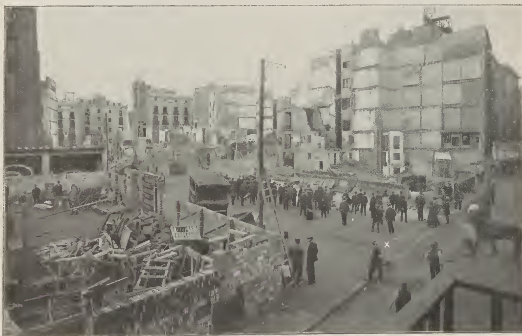
Estado actual de las obras de la reforma. El sitio señalado con una x es el que ocupaba la casa en donde derribó la primera piedra S. M. el rey D. Alfonso XIII en el acto inaugural de la reforma, celebrada el día 10 de marzo del corriente año
