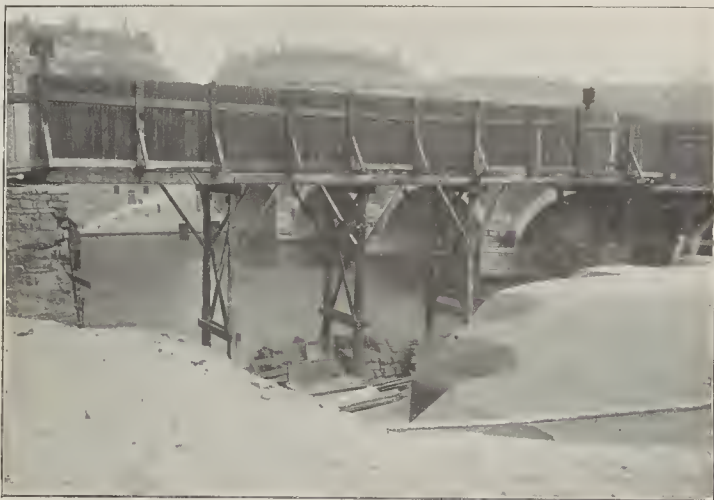
Punto de enlace, en el muelle de las Flores, del cajón y del túnel. En el agua se ven sobresalir dos chimeneas de aire comprimido que se han utilizado para introducir los tres cajones en el lecho del río
