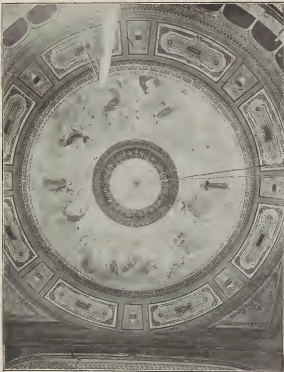
Techo de la sala de espectáculos
