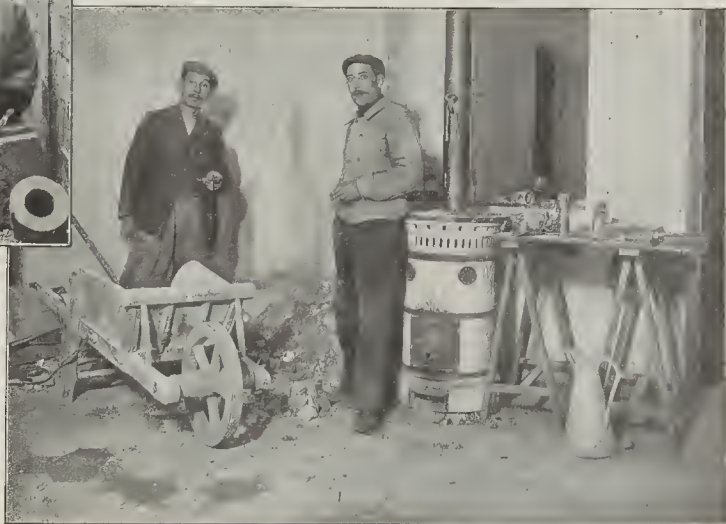
Local en donde estaba instalado el horno de M. Lemoine. (De fotografías de Branger.)
