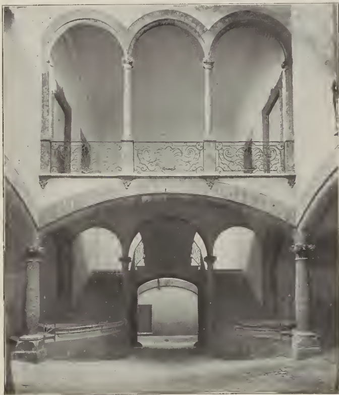
Escalera de la casa Morell
