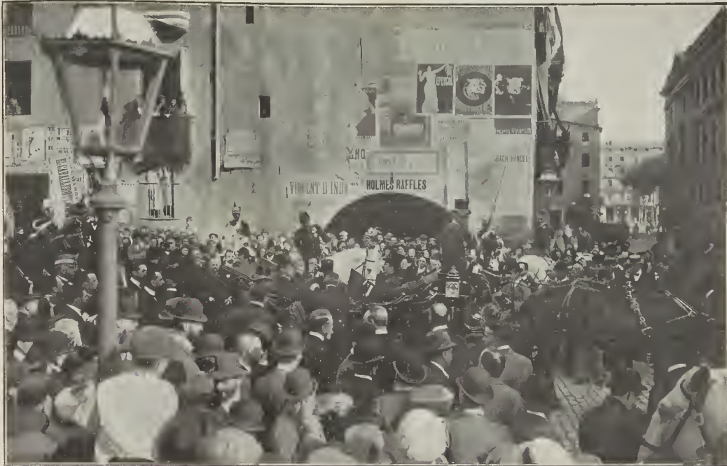
S. M. el rey D. Alfonso XIII visitando las obras de la reforma
