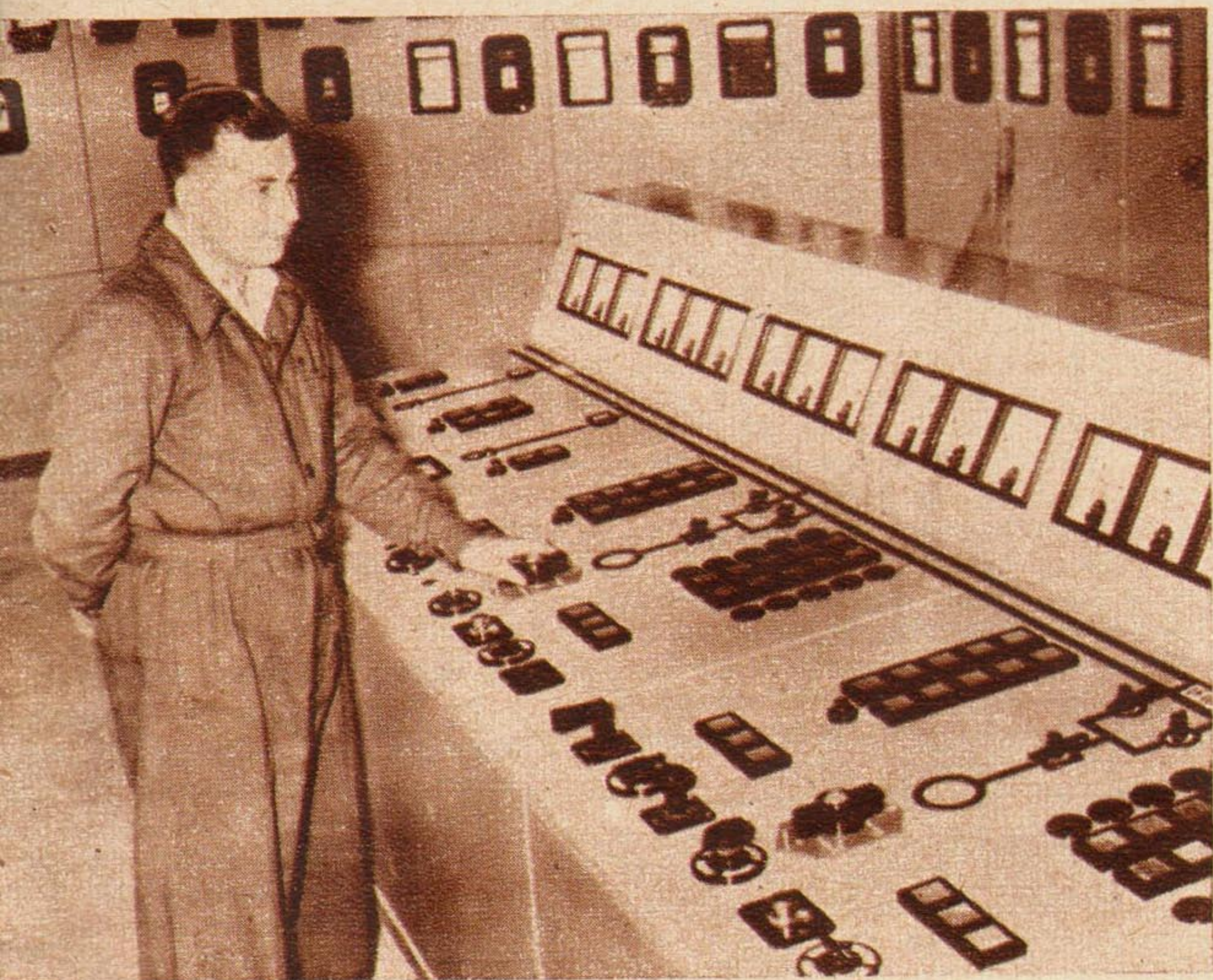
Detalle del tablero de control que mantiene la perfecta coordinación entre las diversas secciones.
