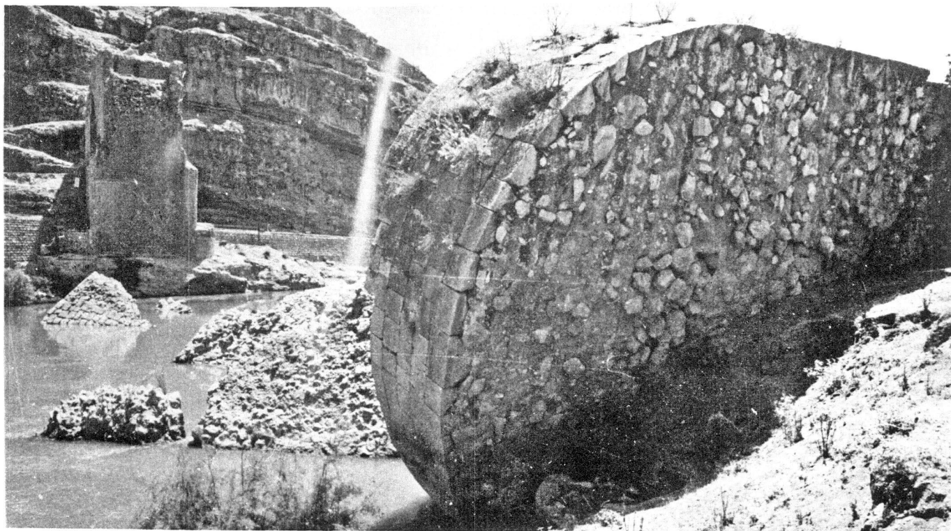
تصویر ۸- در بخش غربی پل دختر ارتفاع رسوبات رودخانه از سطح آب بالغ بر ۱۲ متر میگردد با توجه به ابعاد ۶۰/۲۰×۱۳ متری سطح مقطع پایه فرو غلطیده میتوان میزان ارتفاع رسوبات را لمس نمود
