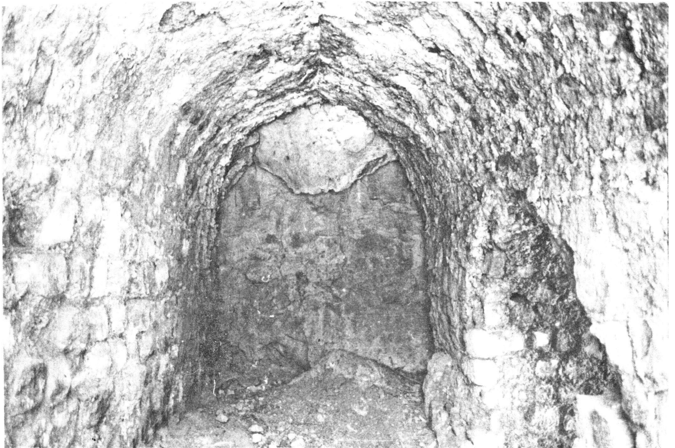
تصویر ۱۴- حجره شمالی بر روی سطح پایه غربی پل با عرض ۲/۹۰ که گوشه‌پوشش راهروی شمالی جنوبی بین محوطه (تصویر
