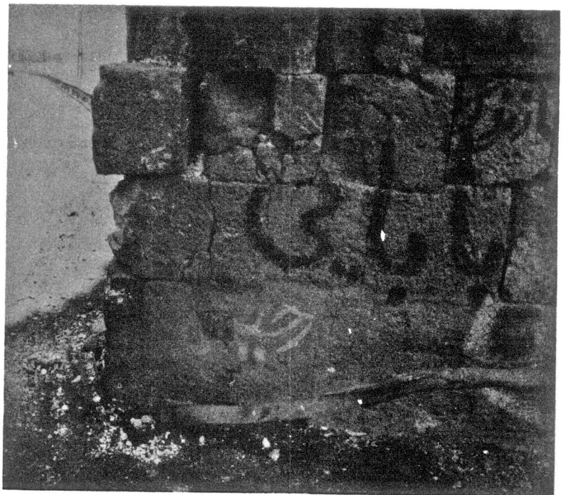
تصویر ۲۲- جابجائی سنگهای پایه سوم شرقی بعلت تصادم با وسایط نقلیه و بار آنها
