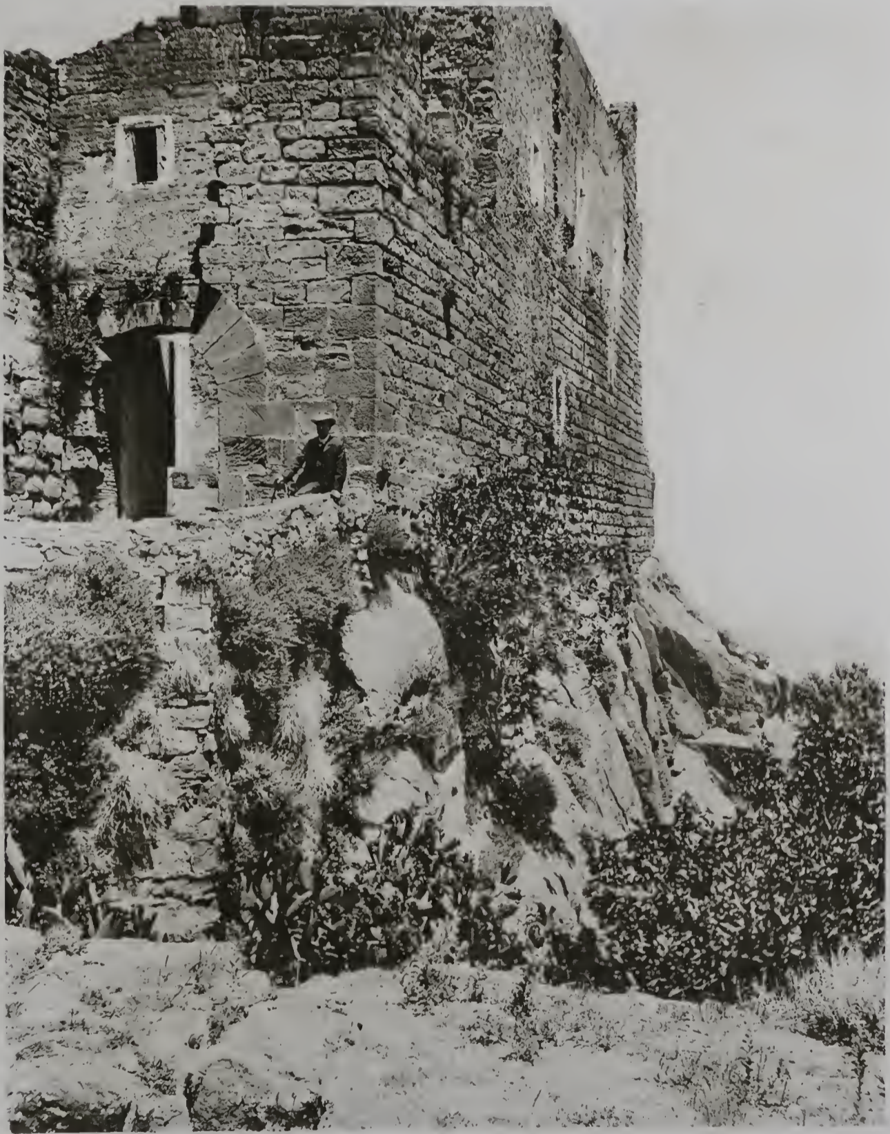
CASTILLO DE ARAMPRUNYÁ (ENTRADA PRINCIPAL)
