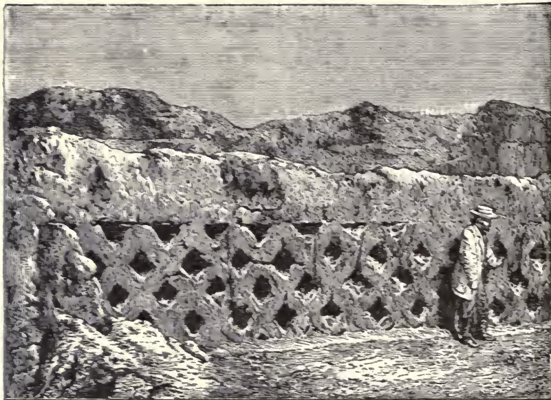
Fig. 163. — Murs en ruine à Chimu.
