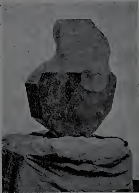
Fig. 68. — Bloc de crown après l'enlèvement à la meule des parties défectueuses.
