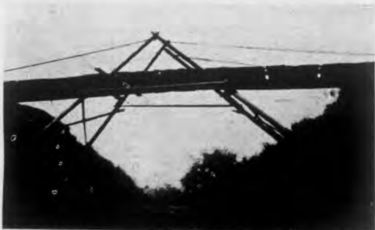
○在橋墩上鋪木板即成一堅固的橋
