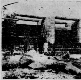
臨時自動壩建築完成後之情形
