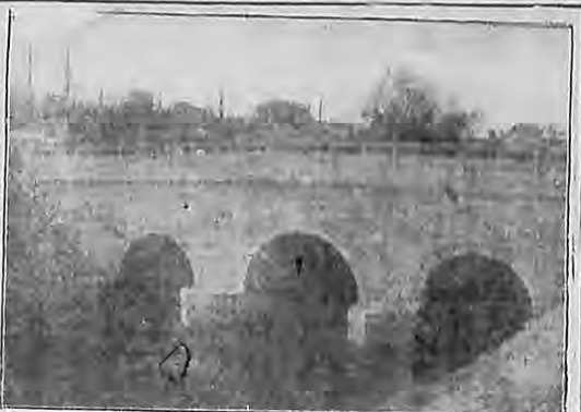
工部告竣之宜武橋
