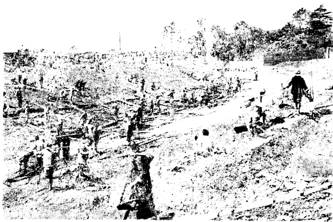
行總以工賑方式發動工人挖浚上海之徐家匯河
