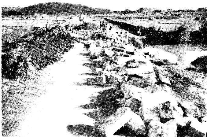
福州至廈門之公路民國廿七年因戰事破壞現由 行總協助逐漸修復圖為採石修路情形
