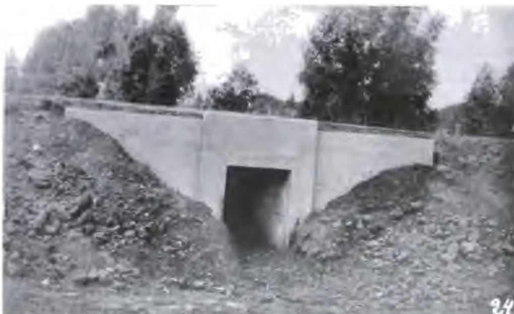
**Obra N° 276, de Ayuda Federal, en el camino de Pieres a Las Nutrias. Modelo de una de las 56 alcantarillas de hormigón armado, ubicadas entre progresivas 11.400 y 52.900. Este camino se halla clasificado en la Red Provincial de primera categoría.**
