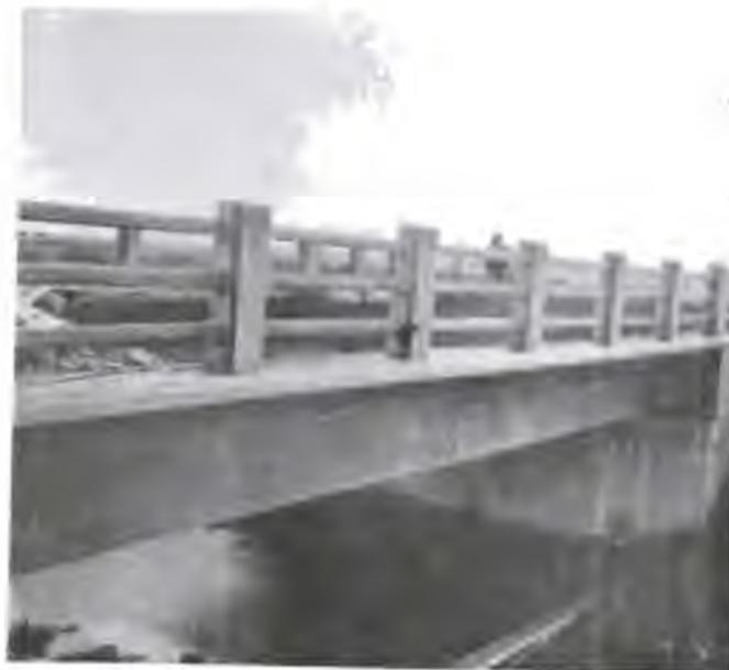
**Obra N° 296, de Ayuda Federal, en el camino de Dufaur a Saavedra. Puente de hormigón armado sobre el arroyo «Chapaleofú», con 15 metros de luz total.**
