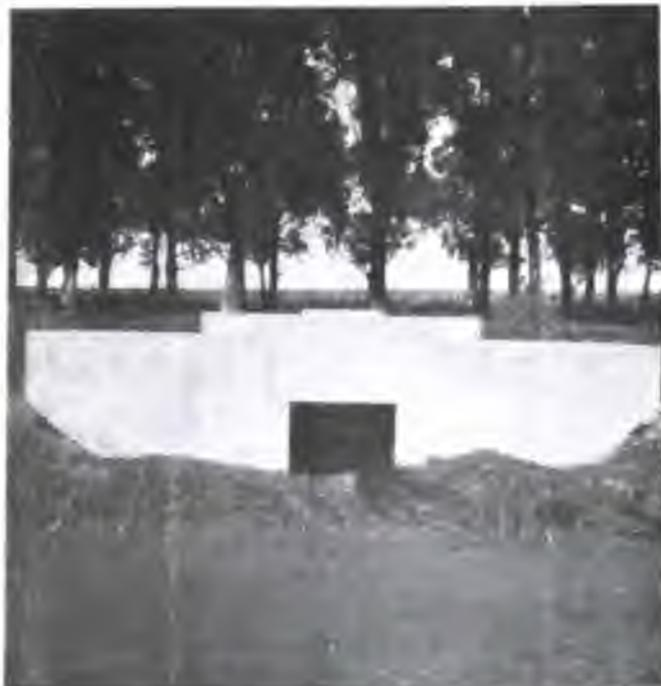
Obra 276 de Ayuda Federal, en el camino de Pieres a Las Nutrias. Modelo de una de las 56 alcantarillas de hormigón armado ubicadas entre progresivas 11.400 y 52.900.
