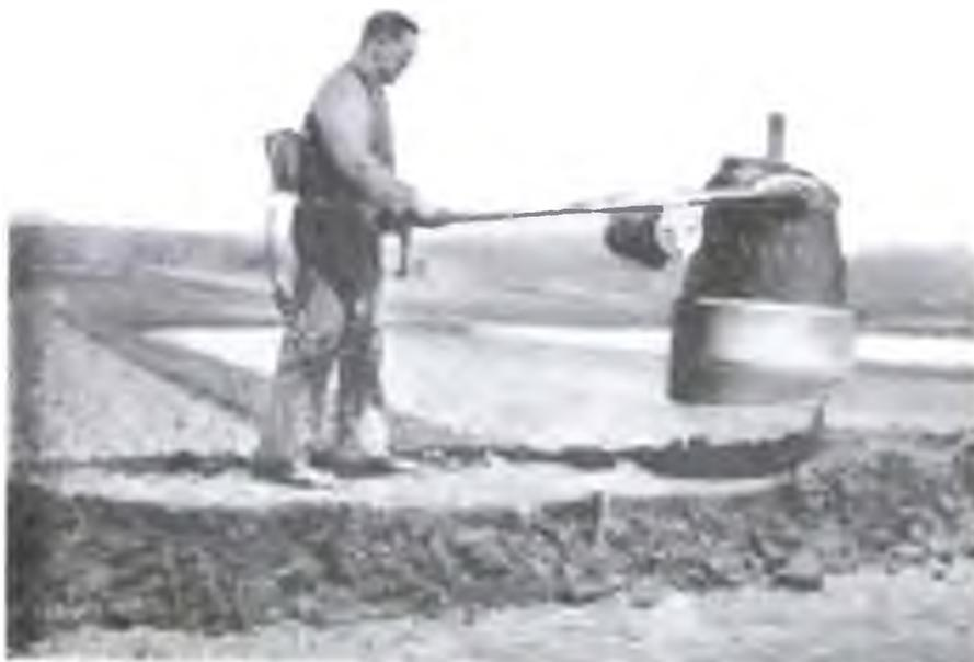
Figura 9. — Compactador dinámico tipo «Sapo».
