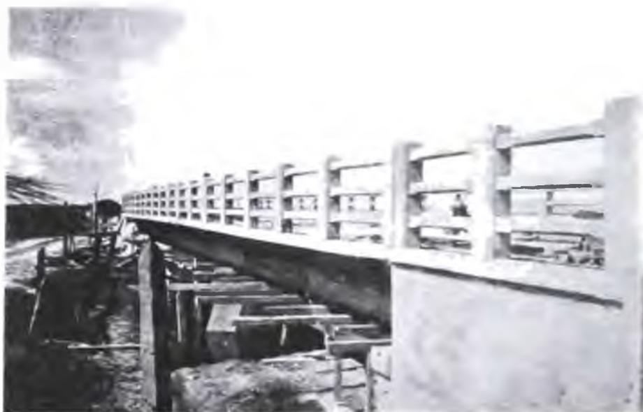
**Obra número 257 de Ayuda Federal, en el camino Costa Sur entre Magdalena y Punta Indio. Puente hormigón armado sobre arroyo «Juan Blanco» de tres tramos de 10 metros de luz cada uno. Luz total 30 metros y seis metros de ancho de calzada.**
