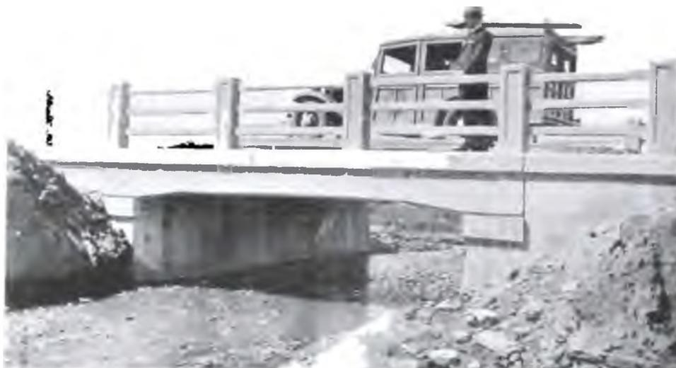
Obra N° 213, de Ayuda Federal, en el camino de Luján a Pilar. Dos puentes de hormigón armado de 5 y 10 metros de luz y 17 alcantarillas.
