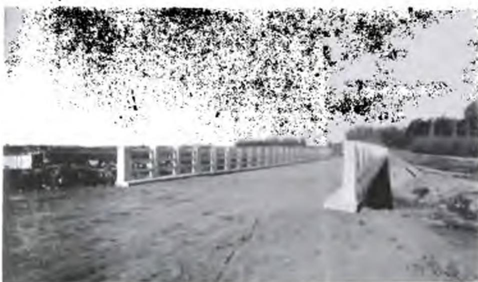
**Obra N° 278, de Ayuda Federal, camino de Capital Federal a Moreno. Alcantarillado y puente a/río Las Conchas (Márquez), de hormigón armado. Puente de tres tramos con 45 metros de luz total y 9 alcantarillas con 6,95 metros de luz total.**
