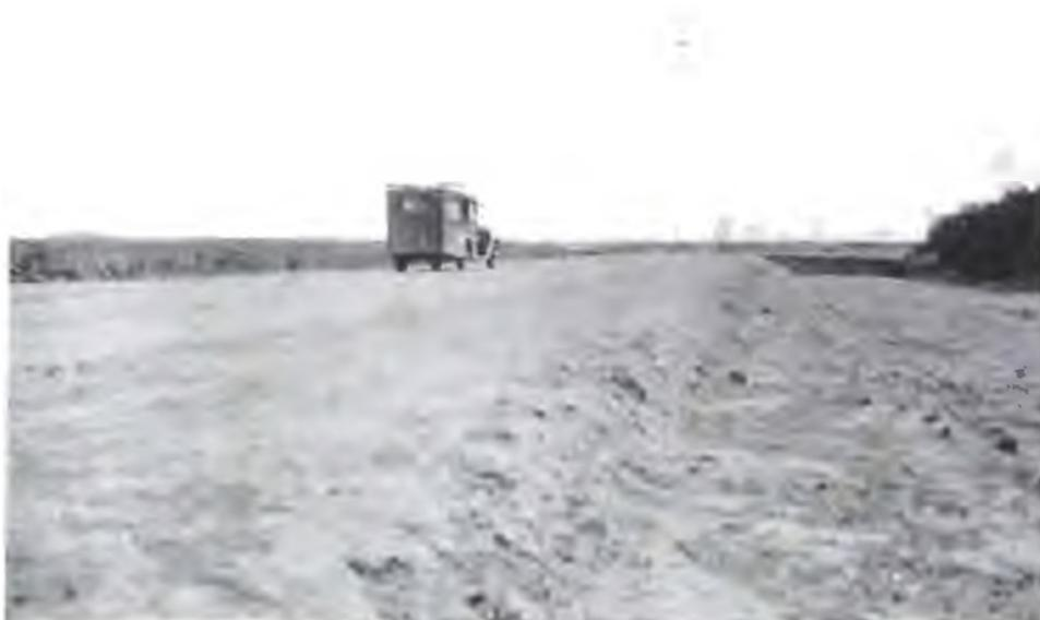
**Obra N° 124, de Ayuda Federal, en el camino de Mercedes a Carmen de Areco. Construcción de Terraplenes, abovedamiento y traslado de alambrados.**
