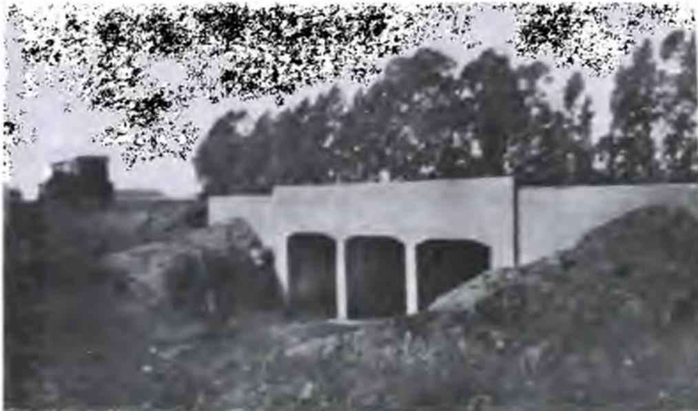
**Obra N° 297, de Ayuda Federal, arreglo en el camino de General Belgrano a Bonnement. Modelo de una de las diez alcantarillas de hormigón armado, con una luz total de 10,85 metros.**
