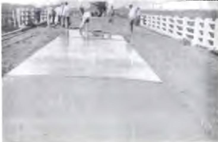
Obra N° 234 de Ayuda Federal, en el camino de La Plata a Brandsen. Pavimento de hormigón armado de 3 metros de ancho de calzada.
