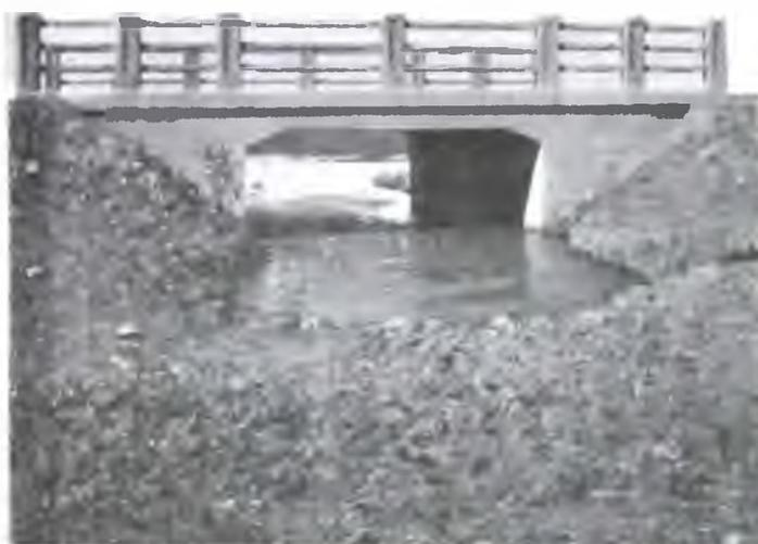
**Obra N° 346, de Ayuda Federal, en el camino de Tandil a Ayacucho. Puente sobre el arroyo «Langueyú» de metal corrugado, con una luz total de 8.12 metros.**
