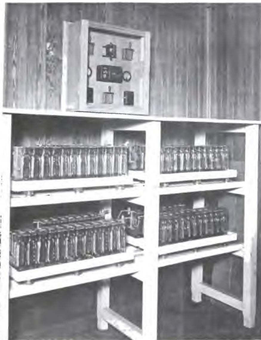
Tren Control — Batería central y aparatos de medición.
