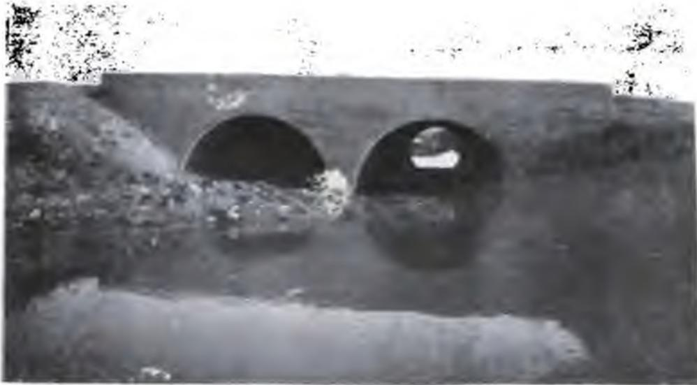
**Obra N° 338, de Ayuda Federal, Calle 11 y 32. Entubamiento del canal, en una longitud de 30 metros. Importe ejecutado: \$ 12.336,96 m/nacional.**
