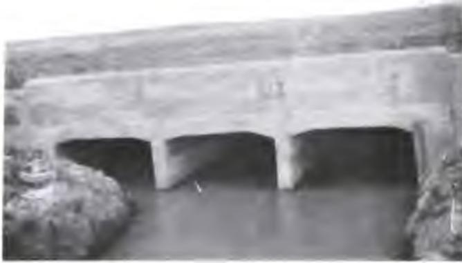
Obra N° 161, de Ayuda Federal, en el camino de Costa Sud, jurisdicción de los partidos de La Plata y Magdalena. Modelo de una de las 46 alcantarillas de hormigón armado con una luz total de 47.25 metros.
