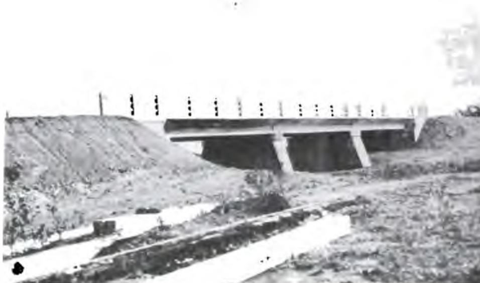
Obra N° 320, de Ayuda Federal, en el camino de Pergamino a Marcelino Ugarte. Puente de hormigón armado s/A. Las Marcieles, de tres tramos de 10 mts. de luz c/u., luz total de 30 mts. y 6 mts. de ancho de calzada.
