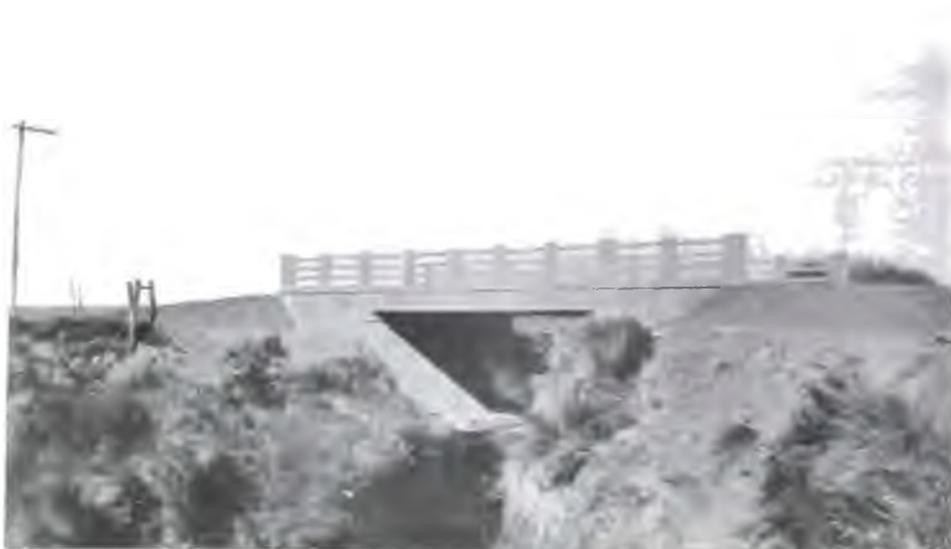
Obra N° 312, de Ayuda Federal. Camino de Saldungaray a Estomba. Puente s/Arroyo «Rivero Chico», de hormigón armado, con una luz total de ocho metros.
