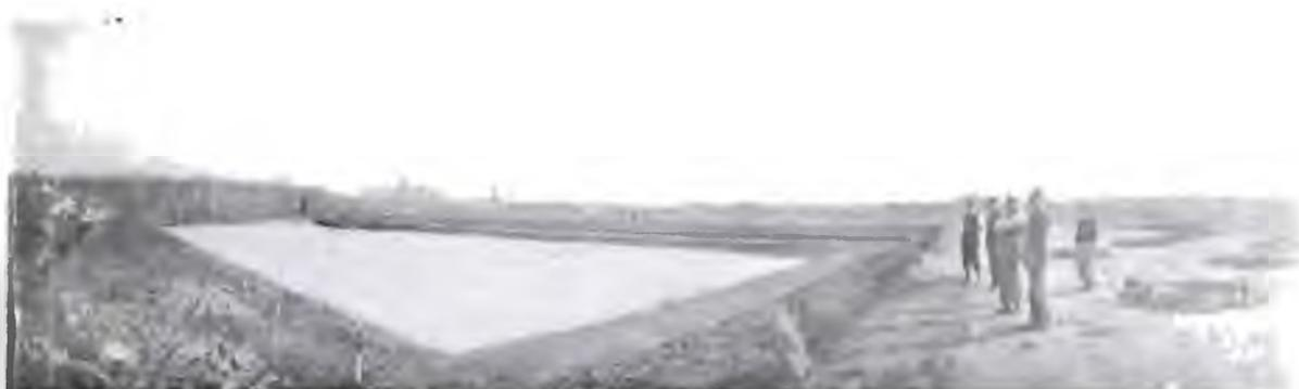
**Vista panorámica de la Dársena y relleno con la tierra extraída en su excavación.
