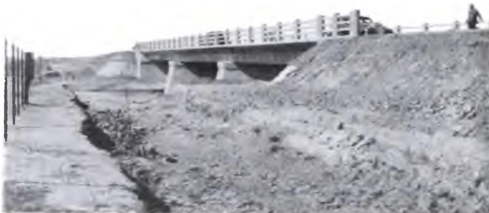
**Obra N° 189, de Ayuda Federal, en el camino de Azul a Crotto. Puente de hormigón armado s/Arroyo «Tapalqué», tres tramos de 15 metros de luz cada uno. Luz total, 45 metros.**
