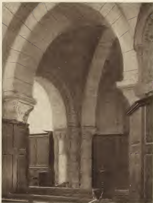
FIG. 14. St. - Pierre, Acy-en-Multien, (Oise). Vault beneath Tower.
