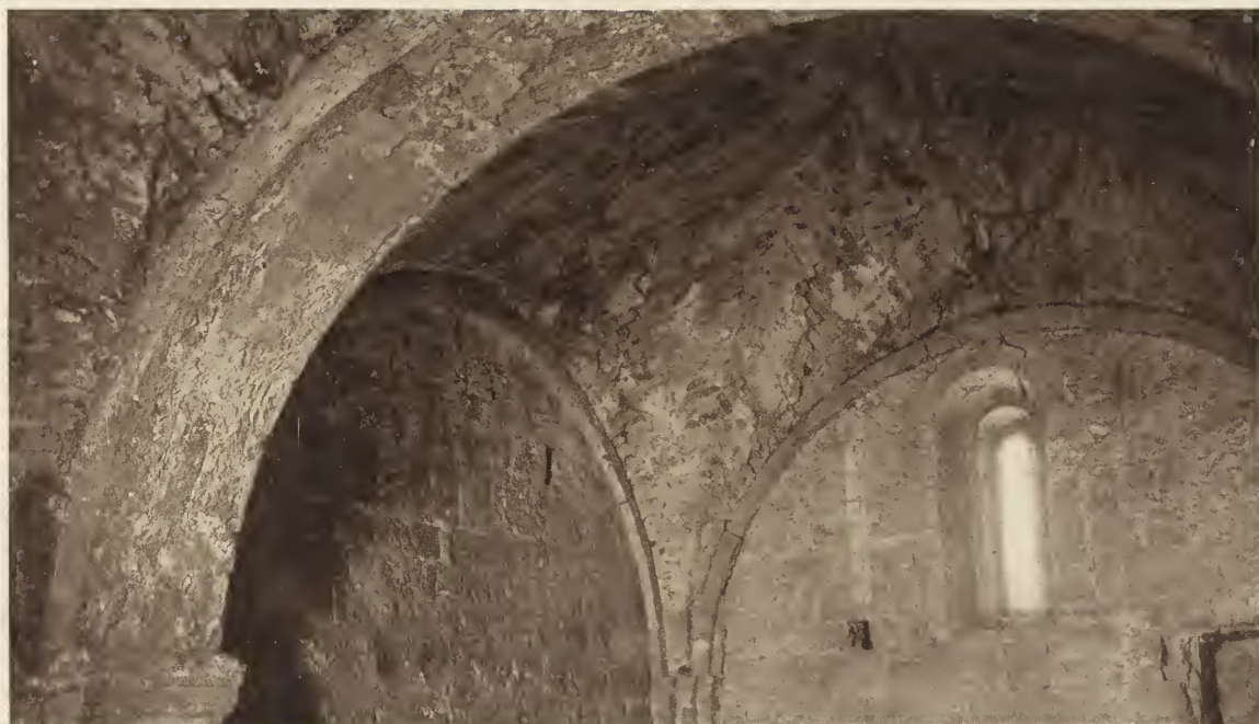
FIG. 41. S. Maria del Solario, Brescia. Vault in crypt.
