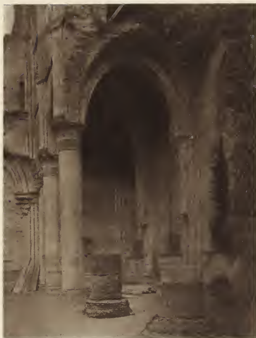
FIG. 32. Abbaye, Longpont, (Aisne). North side aisle.
