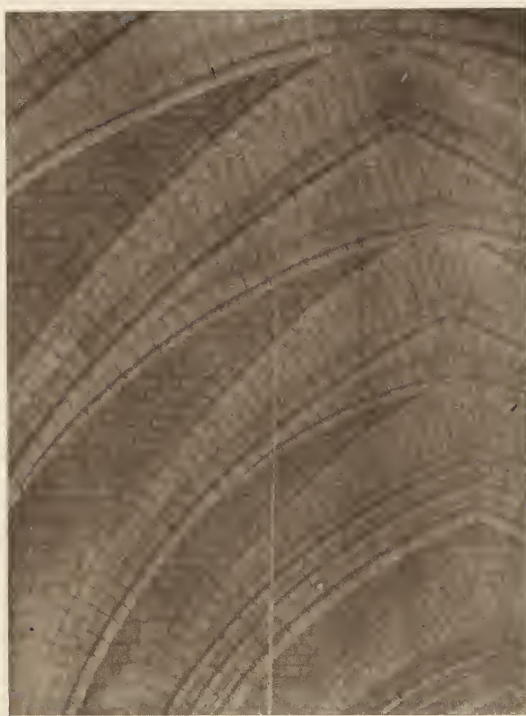
FIG. 10. Cathédrale, Soissons, (Aisne). Nave Vaults.
