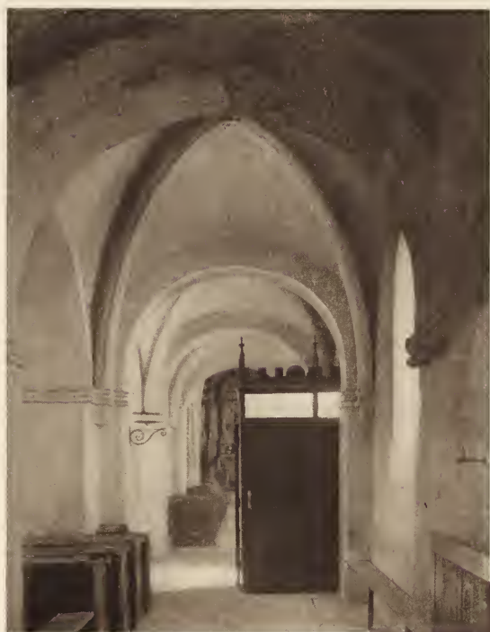
FIG. 11. St. - Pierre, Béthisy - St. - Pierre, (Oise). South side aisle.
