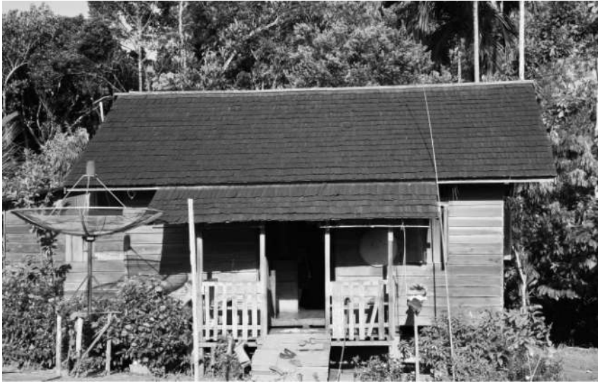
Gambar 9. Salah satu kondisi rumah penduduk Bugau Sumber: Dokumentasi tim, tahun 2016
