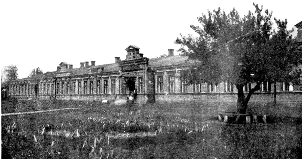
Старий будинок комерційного училища в Катеринославі, де відбувалися перші засідання Катеринославської вченої архівної комісії.
