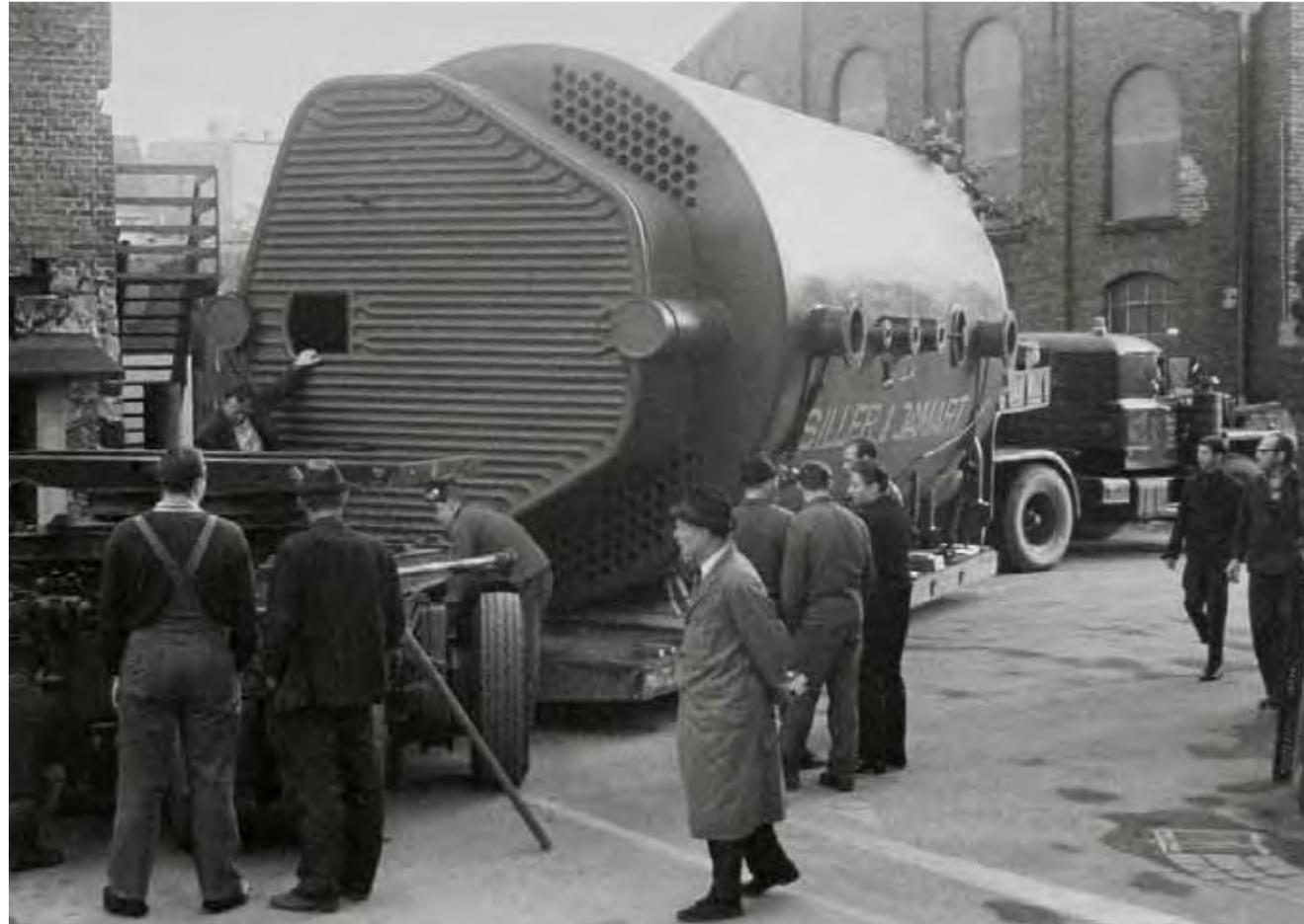
in der Müllverbrennungsanlage installieren. Auch die Stadtwerke stellten zu diesem Zeitpunkt Heißwasserkessel auf dem Gelände an der Giesestraße auf. Die Leistung dieser Kessel betrug 35 Megawatt. 1970 wurde die Müllverbrennung in Betrieb genommen, allerdings gestaltete sich die Müllwärmelieferung zunächst sehr problematisch, so dass vielfach mit den vorhandenen Heißwasserkesseln versorgt wurde. Es waren vier Umwälzpumpen mit einer Förderhöhe von 82 Metern in Betrieb.
