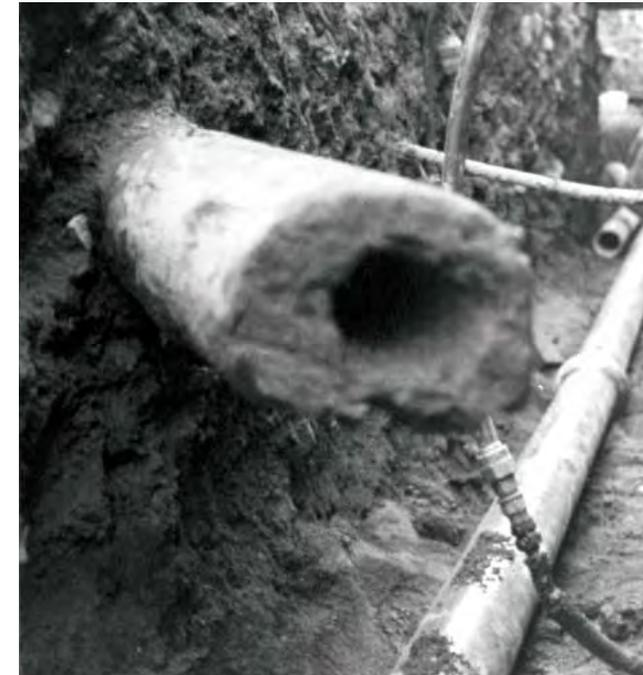
Bei der Neuverlegung von Gas- und Wasserleitungen stoßen Mitarbeiter der Stadtwerke Iserlohn 1968 in der Laarstraße auf alte Holzwasserleitungen. Im Bild die Rohrleger Gerd Hinz und Karl Schmidt.
